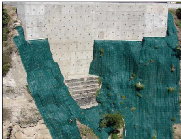
Figura 14. Vista del muro terminado
