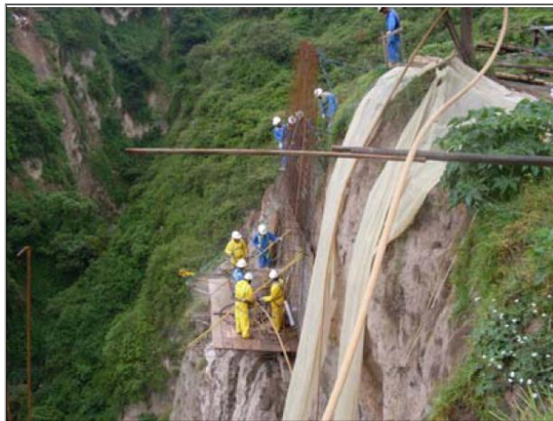
Figura 12. Perforación acrobática de anclajes
