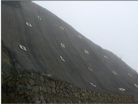
Figura 09. Vista del talud protegido con mallas y clavos
