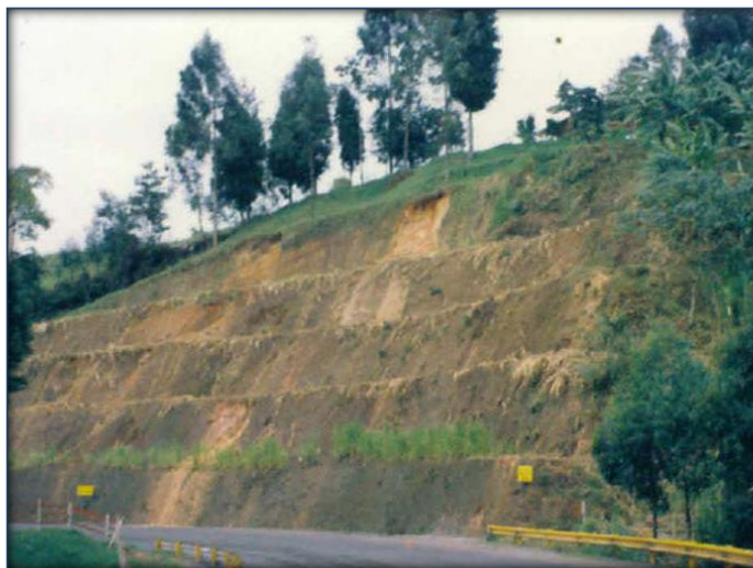
Figura 29. Conformación de terrazas en taludes Fuente. MATAIX Carmen, Técnicas de revegetación de taludes
