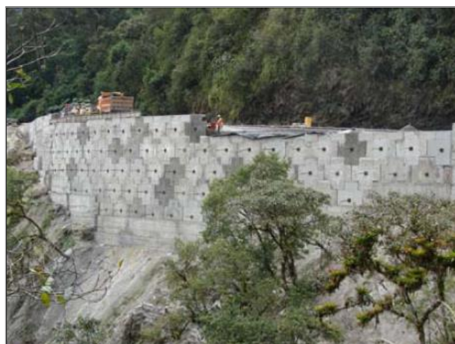
Figura 15. Vista general de la construcción de Geopantallas Ancladas
