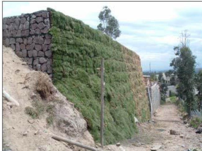
Figura 17. Recuperación de terrenos con gaviones reforzados
