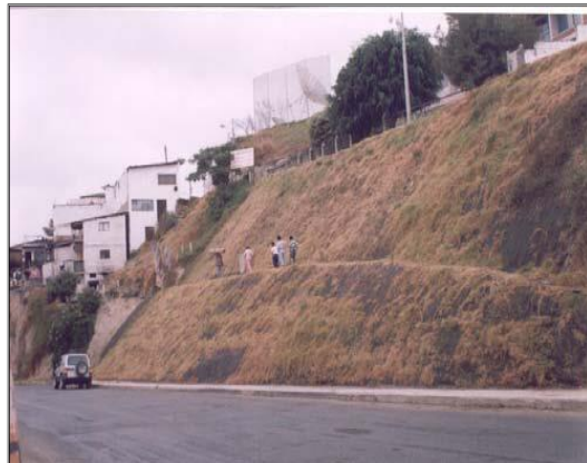
Figura 06. Talud poco tiempo luego de la restauración
