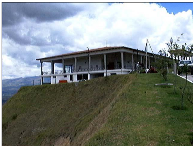
Figura 01. Vista del Talud previo al deslizamiento
