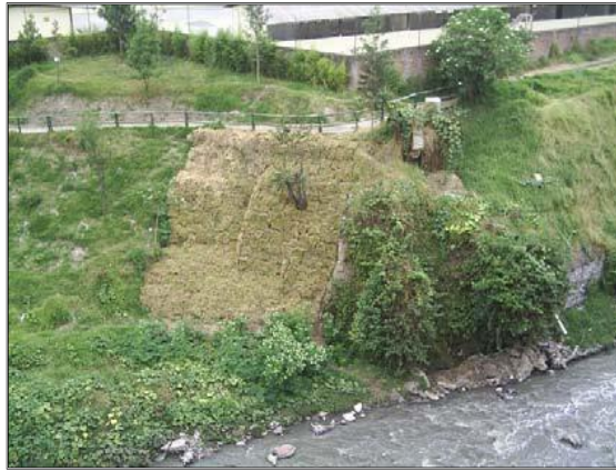
Figura 07. Vista de un talud restaurado con geocontenedores de suelo cemento, malla y claveteado
