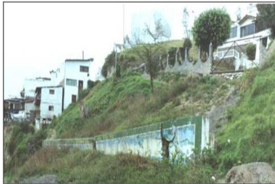
Figura 05. Vista del talud deslizado
