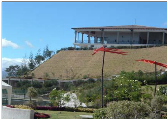
Figura 04. Vista del estado actual del talud restaurado
