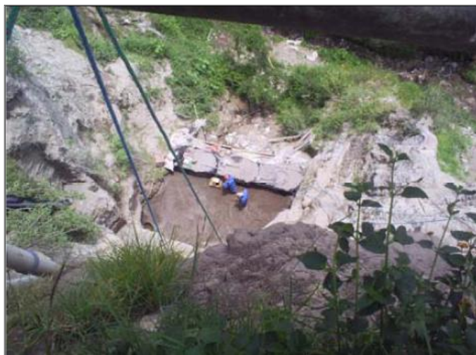
Figura 10. Preparación de la cimentación y gaviones de suelo cemento Fuente. LANDÁZURI y PEÑAHERRERA, Experiencias en Restauración de Taludes y Recuperación de Terrenos en Zonas de Alta Pendiente
