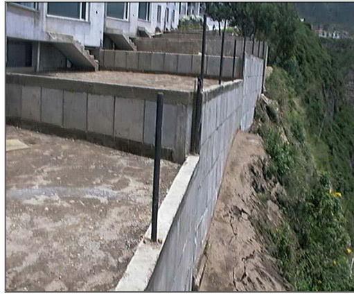
Figura 18. Muro de placas con suelo reforzado
