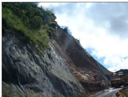
Figura 08. Vista de un talud fallado
