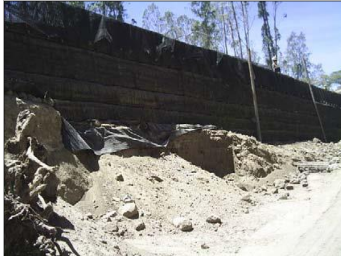
Figura 16. Construcción de un talud de suelo reforzado con geomalla
