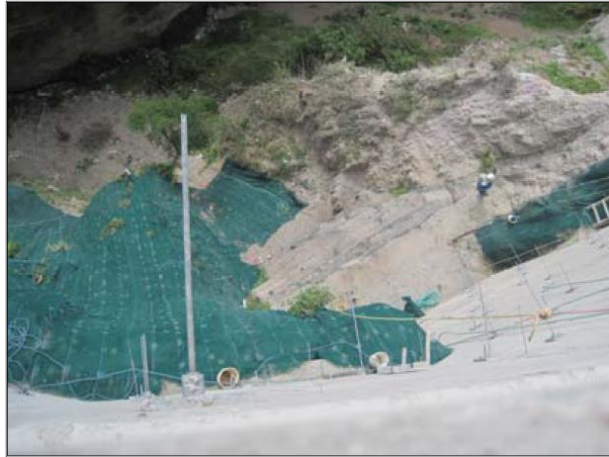
Figura 13. Parte integral del muro es la protección de erosión
