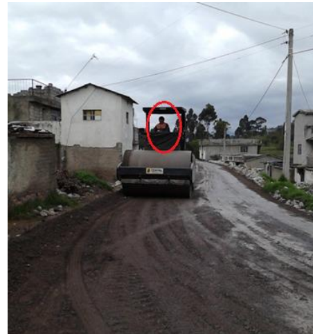
Fotografía 49.- Compactación; material de la Base
