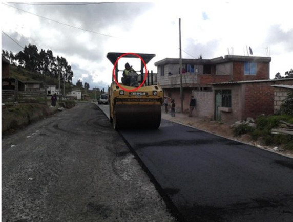
Fotografía 58.- Carpeta Asfáltica, Compactación Actividad productiva: Operador Rodillo
