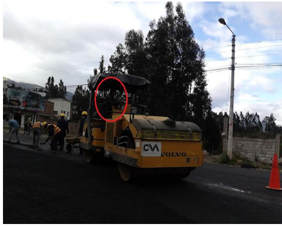
Fotografía 28.- Carpeta asfáltica, Compactación
