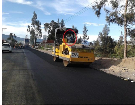
Fotografía 30.- Carpeta asfáltica, Compactación Actividad Productiva: Operador del rodillo
