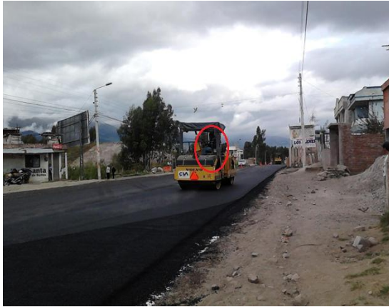
Fotografía 29.- Carpeta asfáltica, Compactación Actividad Productiva: Operador del rodillo
