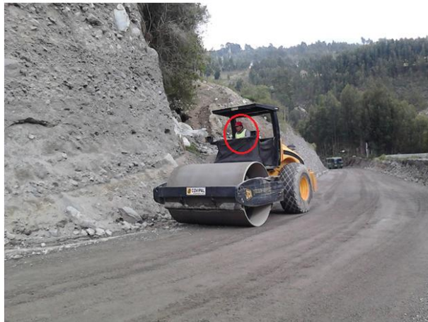
Fotografía 41.- Compactación de la sub base
