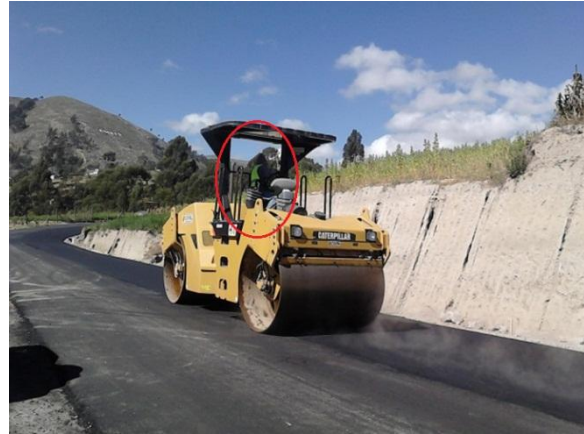
Fotografía 59.- Carpeta Asfáltica, Compactación Actividad productiva: Operador Rodillo
