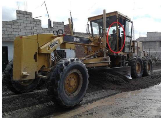
Fotografía 43.- Tendido material de la Base
