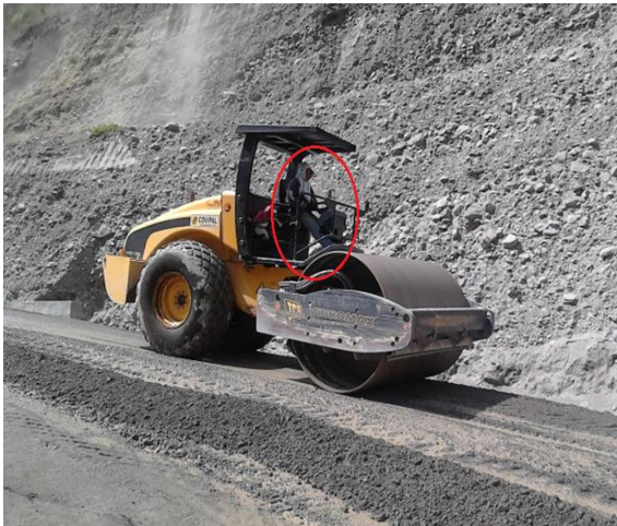
Fotografía 48.- Compactación; material de la Base
