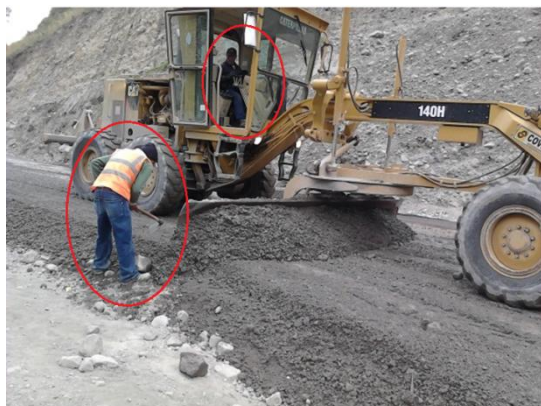
Fotografía 42.- Tendido material de la Base
