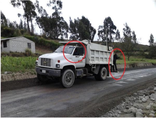
Fotografía 39.- Hidratación de la sub base
