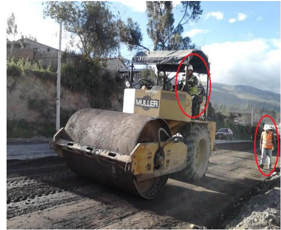
Fotografía 12.- Compactación material base
