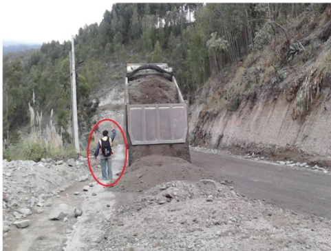
Fotografía 35.- Descarga de material de la sub base.
