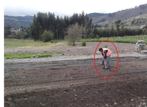
Fotografía 38.- Tendido material sub base
