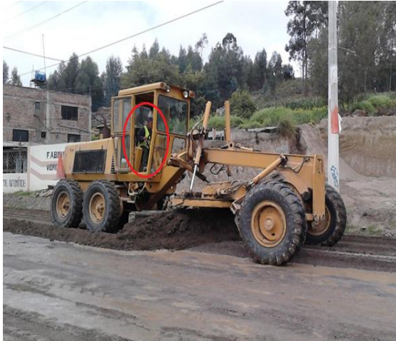
Fotografía 5.- Tendido material de la base
