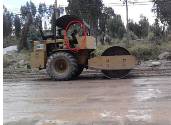
Fotografía 14.- Compactación material base
