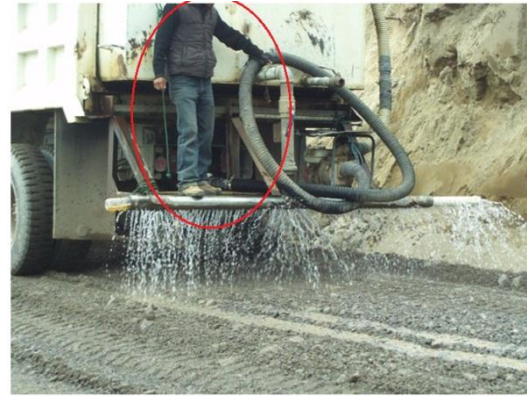
Fotografía 40.- Hidratación de la sub base
