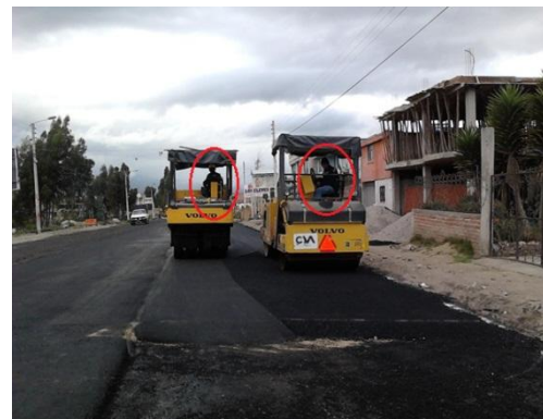
Fotografía 34.- Carpeta asfáltica, Compactación y Sellado Actividad Productiva: Operador del rodillo y Operador del Tampo
