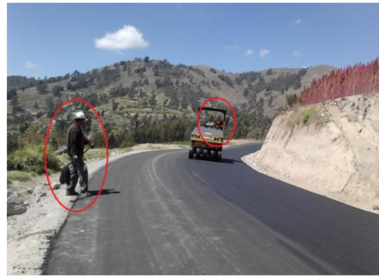
Fotografía 61.- Carpeta Asfáltica, Sellado
