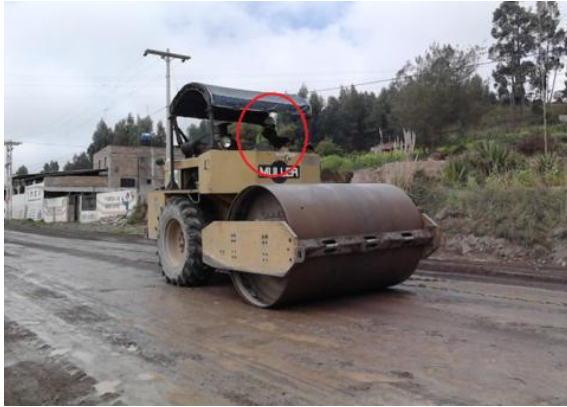
Fotografía 13.- Compactación material base
