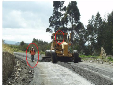
Fotografía 36.- Tendido material sub base
