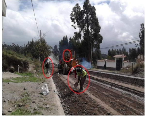
Fotografía 6.- Tendido material: base
