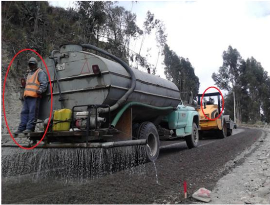
Fotografía 46.- Hidratación y compactación; material de la Base
