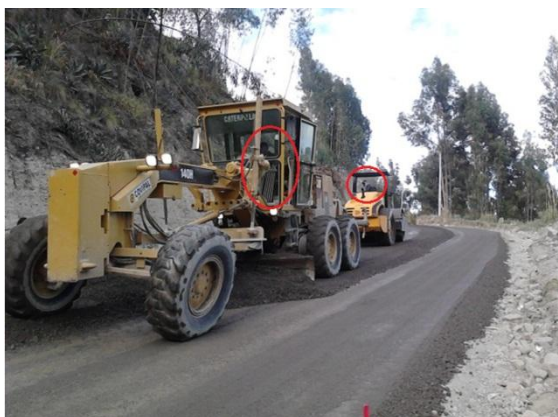
Fotografía 44.- Tendido y compactación; material de la Base
