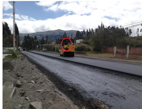
Fotografía 32.- Carpeta asfáltica, Sellado Actividad Productiva: Operador del Tampo
