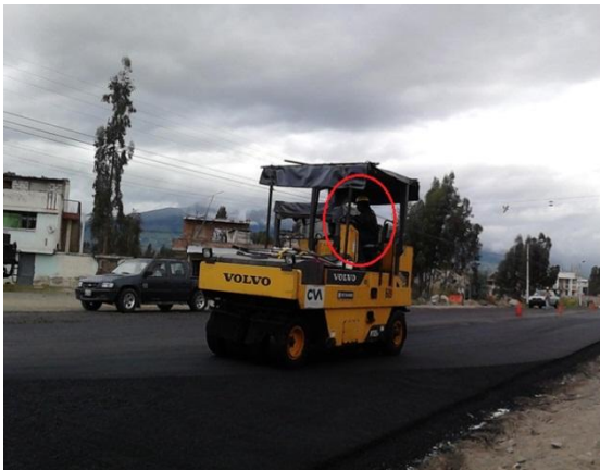
Fotografía 31.- Carpeta asfáltica, Sellado Actividad Productiva: Operador del Tampo
