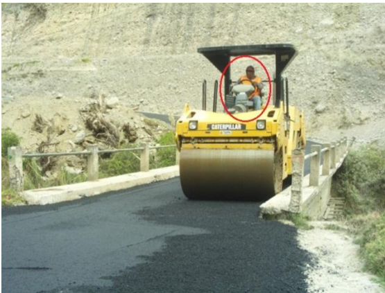
Fotografía 60.- Carpeta Asfáltica, Compactación
