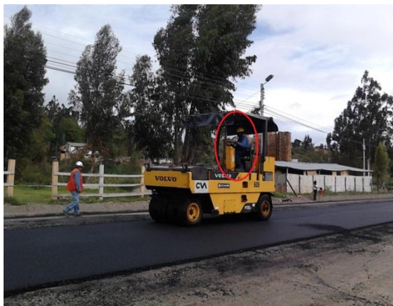
Fotografía 33.- Carpeta asfáltica, Sellado Actividad Productiva: Operador del Tampo
