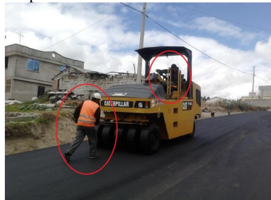
Fotografía 63.- Carpeta Asfáltica, Sellado Actividad productiva: Operador y Ayudante del Tampo
