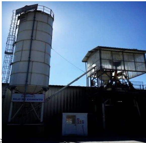
Figura 4.-Silo de Cemento Tipo 10 P.
