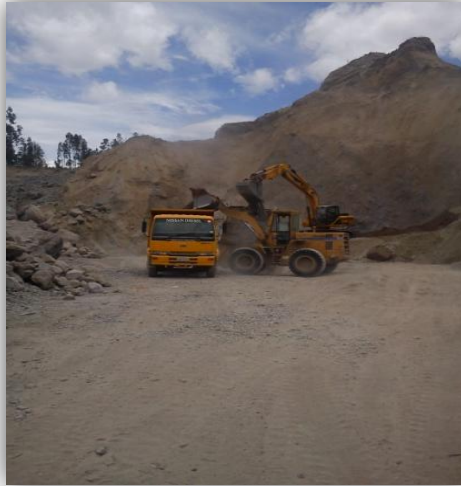
Figura 54.- Cargando en las volquetas el Ripio ¾ in
