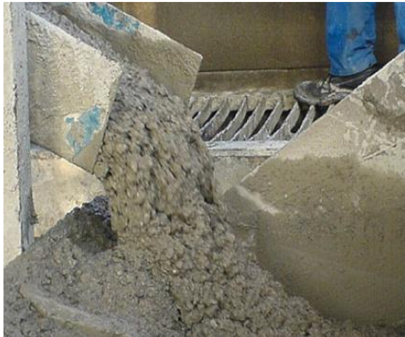
Figura 58.- Fabricación de grandes volúmenes de hormigón.
