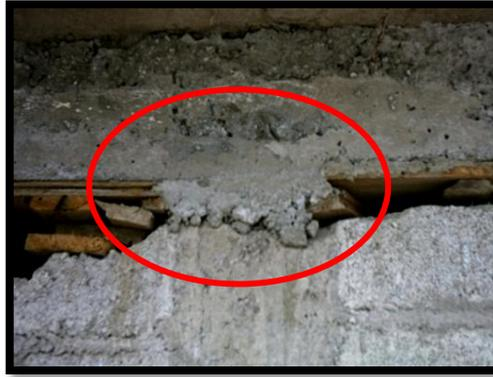
**Figura 23.**Elementos anclados de manera poco eficiente. Vivienda A41
