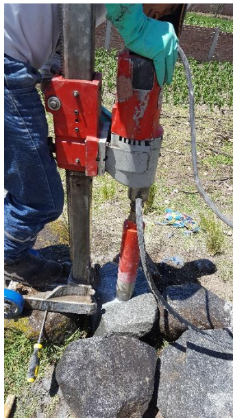
Figura 84. Extracción de núcleos de roca.
