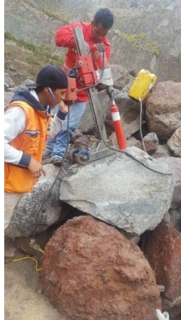
Figura 11. Extracción de núcleos de roca
