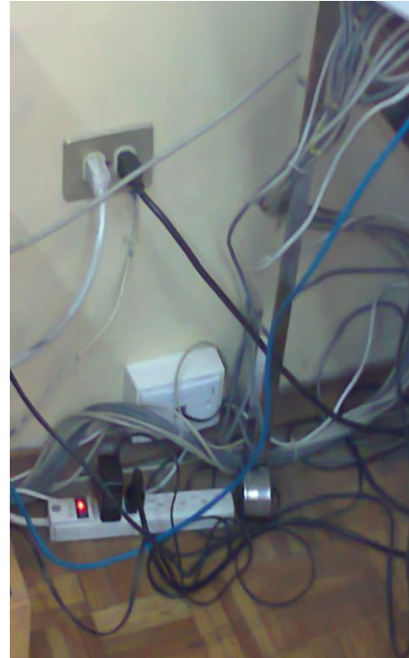
Figura 37: Cables sin canaletas
