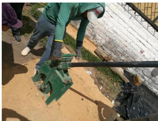
**Fotografía 18:** Aplicación de fuerza en los mampuestos con la palanca.
