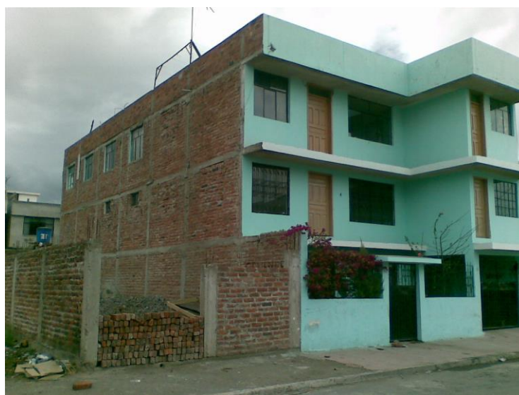
Figura 5. Edificación con columnas de sección menor que 900cm 2 , Barrio 24 de Mayo (N 9818422; E 758383; altura 2857m.s.n.m.)
