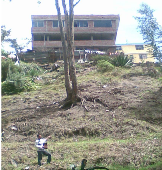
Figura 17. Construcciones en suelos Inestables, Barrio La Florida (N 9813888; E 761329; altura 2731 m.s.n.m.) ELABORADO POR: JP - MT
