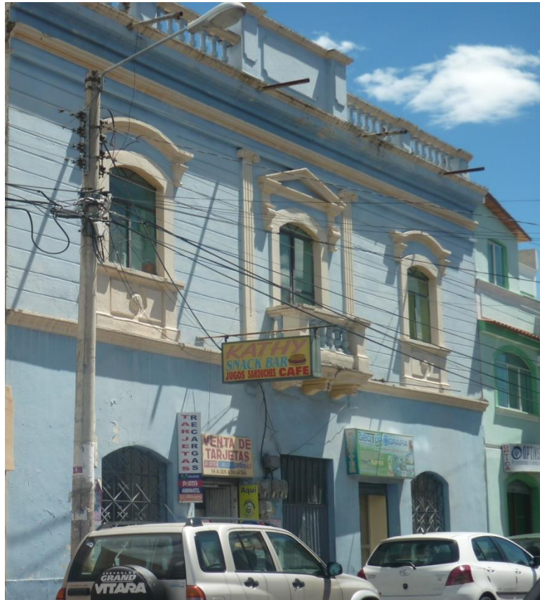
Figura 21. Edificación de adobe Barrio la Panadería. (N 9815748; E 7657781; altura 2790 m.s.n.m.) ELABORADO POR: JP - MT
