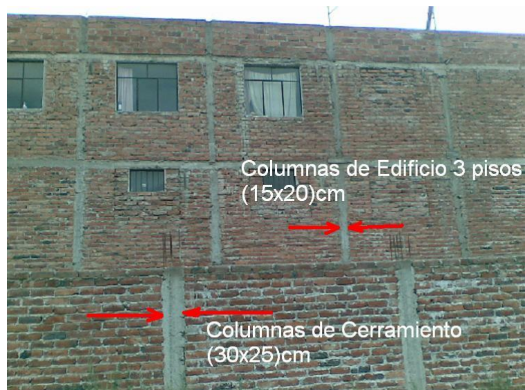
Figura 4. Columnas de secciones menores que 900cm 2 , Barrio 24 de Mayo (N 9818422; E 758383; altura 2857m.s.n.m.)
