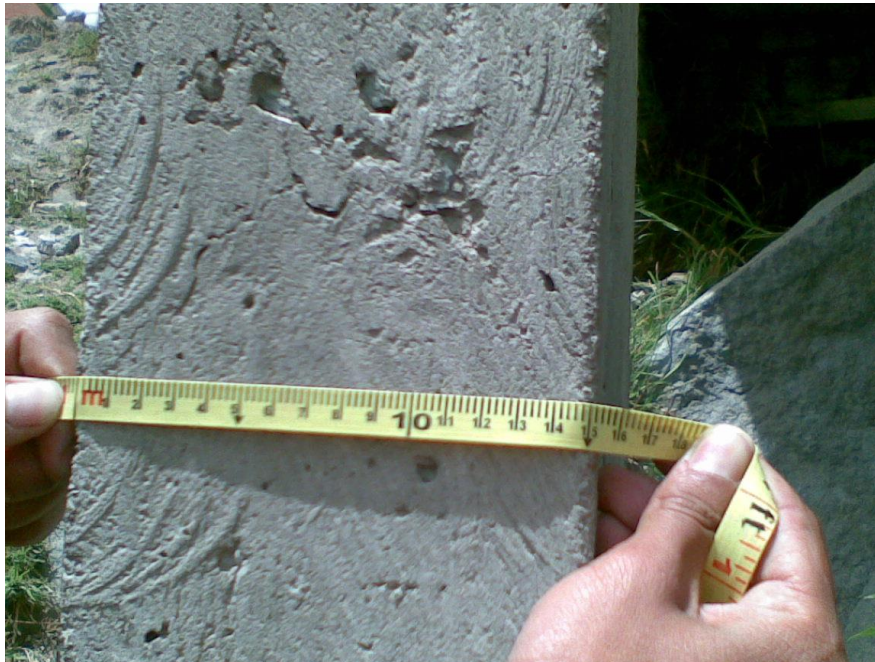
Figura 8. Columnas (15X20)Barrio 11 de Noviembre. (N 9816822; E 762571; altura 2795m.s.n.m.) ELABORADO POR: JP - MT
