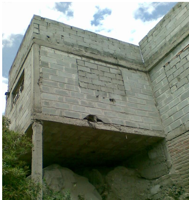
Figura 7. Columnas de (15X20)cm, Barrio 11 de Noviembre (N 9816822; E 762571; altura 2795m.s.n.m.) ELABORADO POR: JP - MT
