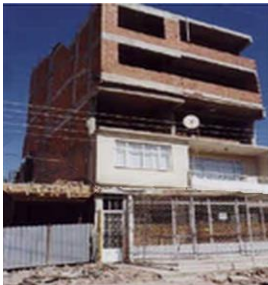
Gráfico 7. Casa informal de cinco pisos que originalmente fue de dos pisos Fuente: http://www.tdcat.cesca.es/TESIS_UPC/AVAILABLE/TDX-0416102-075520/07Capitulo5.PDF
