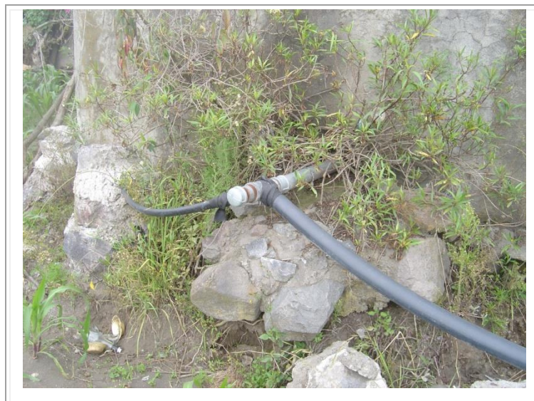
Foto 3.2 Inicio de la conducción con manguera negra
