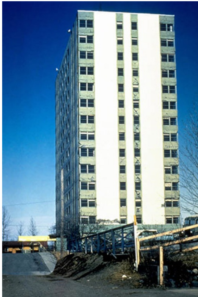
Figura 20. Vista de la fachada del Centro Médico Indian Hills
