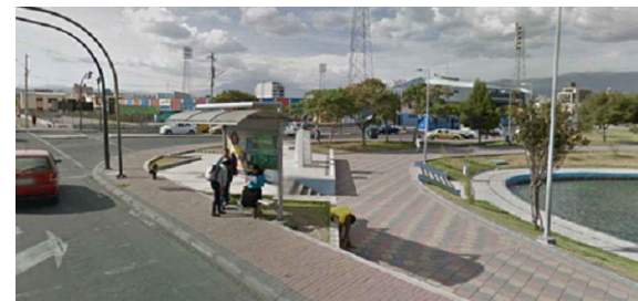
④ Accesibilidad muy insuficiente ACERA: 2.50m PENDIENTE: ninguna- presencia de gradas
