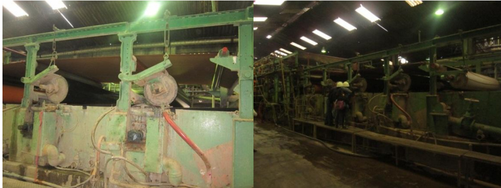
Imagen 1: Máquina en Movimiento Riesgo de Atrapamiento Elaborado por: Teresa Sánchez
