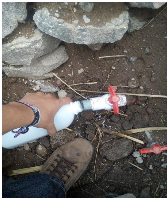
Anexo 6.4.- Toma de muestra del efluente de agua tratada en el sistema piloto a los 45 días de funcionamiento.
