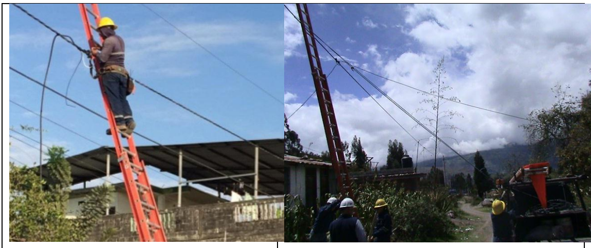
Fotografía 4.2. Trabajos de Anclaje y conexión de Acometidas en Redes de BT
