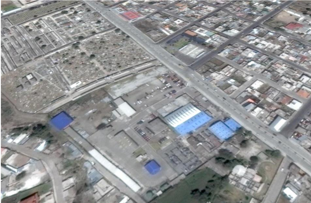
Fotografía No. 1.1. Sub estación No. 1 Empresa Eléctrica Riobamba S.A.
