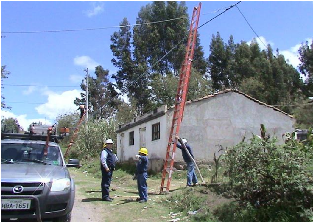
Fotografía No. 1.2. Anclaje de escalera telescópica a red pre ensamblada.
