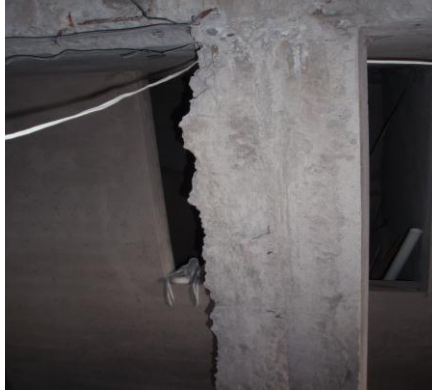
Gráfico 101. Columna con insuficiente área de concreto y acero.
