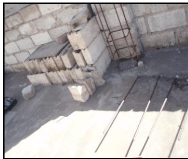
Gráfico 51. Elementos anclados de manera poco fiable de la vivienda F_09_2P
