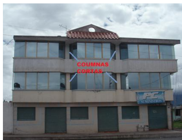
Gráfico 4. Columnas Cortas M_08_3P
