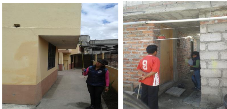
Gráfico. 92 Viviendas con problemas de Asentamiento.
