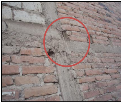
Gráfico 49. Juntas de Construcción de la vivienda F_09_2P
