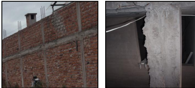
Gráfico 19 . Confinamiento del Concreto.
