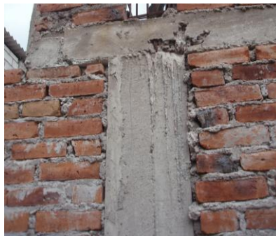
Gráfico 104. Columna con insuficiente área de concreto y acero.
