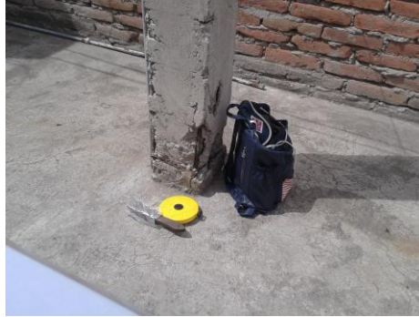
Gráfico 103. Columna con insuficiente área de concreto y acero.
