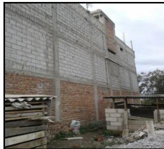
Gráfico 38. Mampostería de Bloque
