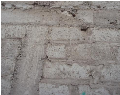
Gráfico 102. Columna con insuficiente área de concreto y acero.
