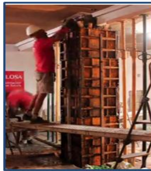
Gráfico 98. Vertido de hormigón.
