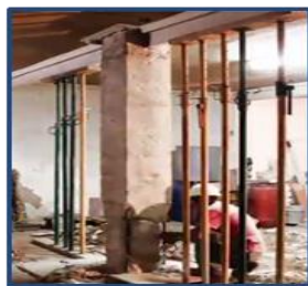
Gráfico 96. Cambio de acero dañado.
