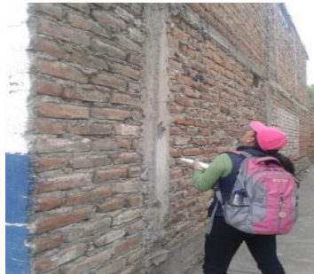
Gráfico 7. Discontinuidad en vivienda B_25_2P
