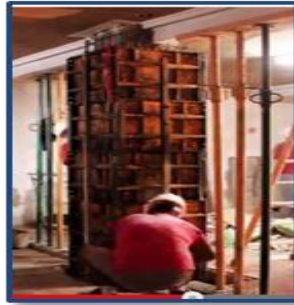
Gráfico 97. Encofrado de columnas
