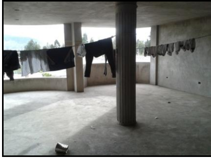
Gráfico 40. Sistema de pisos - Losa de Hormigón Armado
