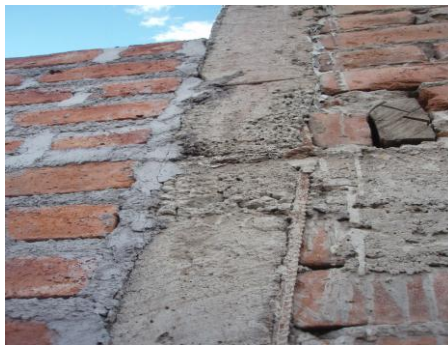
Gráfico. 100 Columna con insuficiente área de concreto y acero.
