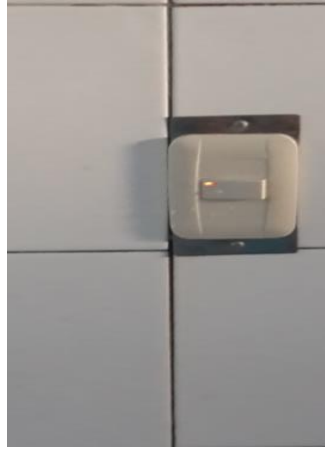
Cambio de interruptores.
