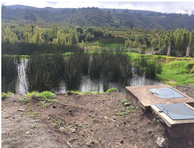
Anexo 8. Planta de tratamiento de la Parroquia San Gerardo actualmente inhabilitada. Fuente: Elaboración Propia.
