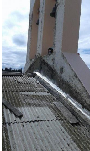
Figura 51. Hugo Coello. (Cunduana 2017). Techo exterior
