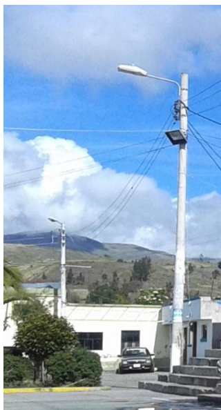
Figura 42. Hugo Coello. (Cundwana 2017). Tendido eléctrico en la comunidad de San José de Cundwana.
