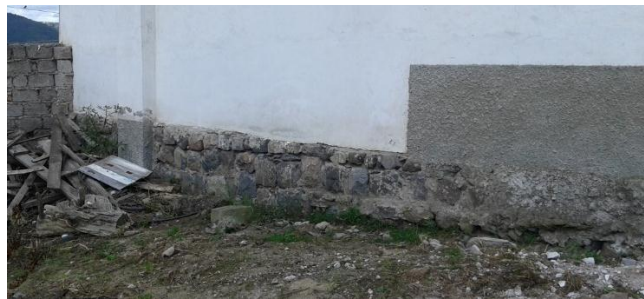
Figura 47. Hugo Coello. (Cunduana 2017). Cimentación del templo.
