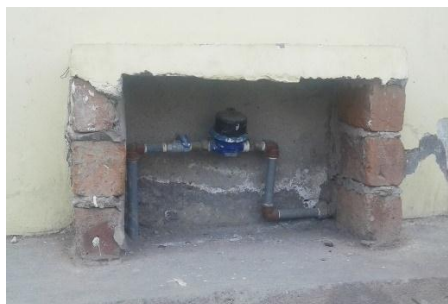
Figura 41. Hugo Coello. (Cundwana 2017). Sistema de medidores para el control en el suministro de agua potable.
