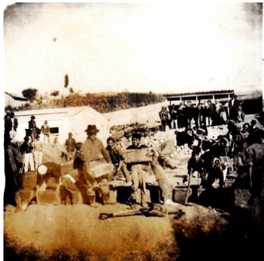
Figura 22. Familia Coello Parreño. (Cundwana 1956). Producción de bloques de terro-cemento. Preparación de la mezcla y elaboración de los bloques de terro-cemento.
