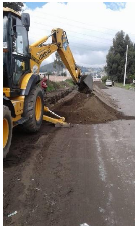
Figura 43. Hugo Coello. (Cunduana 2017). Trabajos de ejecución de la segunda etapa del alcantarillado.
