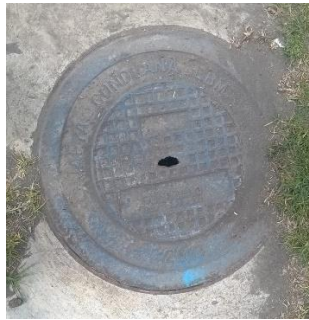
Figura 45. Hugo Coello. (Cunduana 2017). Tapas de revisión del sistema de alcantarillado.
