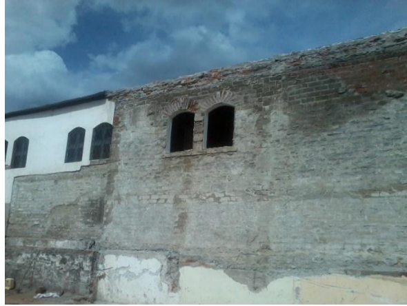
Figura 49. Hugo Coello. (Cunduana 2017). Mamposterías perimetrales de terro-cemento.
