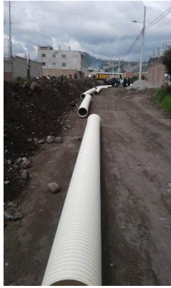
Figura 44. Hugo Coello. (Cunduana 2017). Tubería destinada para el alcantarillado
