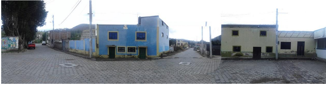
Figura 54. Hugo Coello. (Cundduana 2017). Fachada oeste calle Primero de Enero
