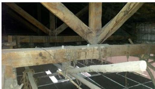
Ilustración 11. Cercha de madera tipo A
