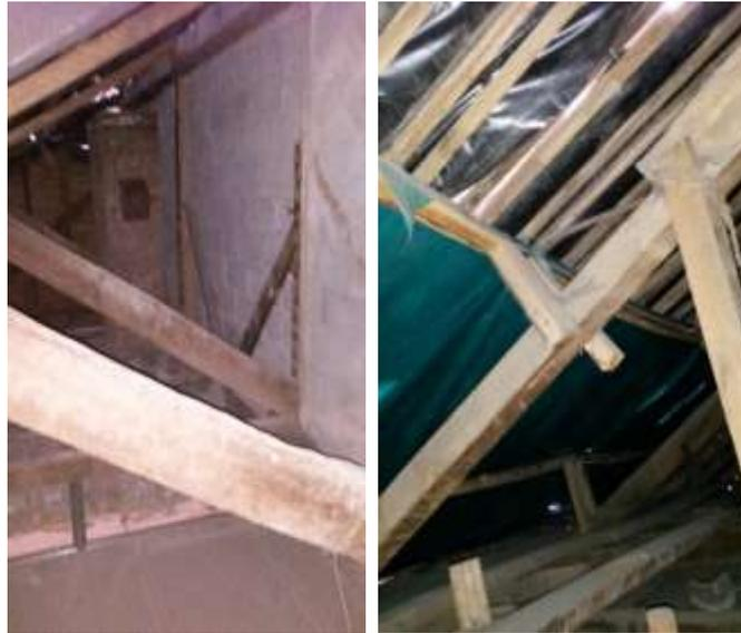
Ilustración 30. Cercha de madera tipo C
