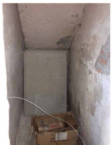
Patología: Humedad, desprendimientos 1.- Desprendimiento de revestimiento y acabado en el nártex (bajo la escalera)
