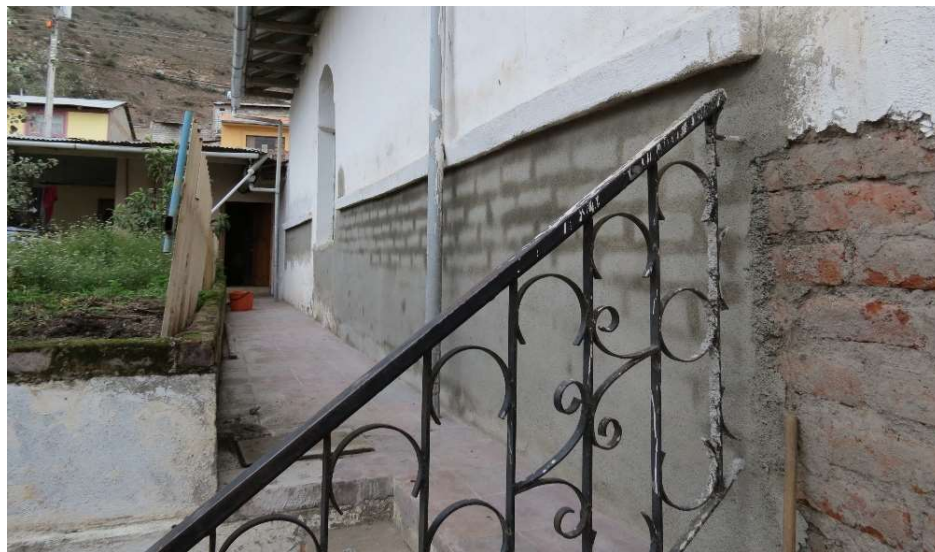
Fotografía 36. Reparación de muro lateral izquierdo. Fuente: El Autor
