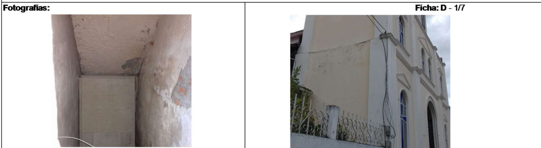
Desprendimientos de enlucido y pintura en mampostería Humedad y desprendimientos en muros laterales
