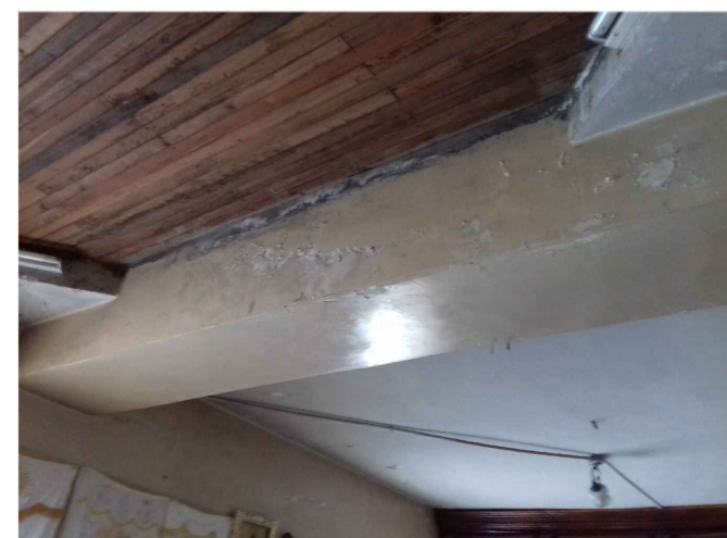
Patología: Humedad, eflorescencia, deformación 9 - Deformación de elementos del entripo, desprendimientos en la unión viga - entripo del campanario por las eflorescencias que se observan
