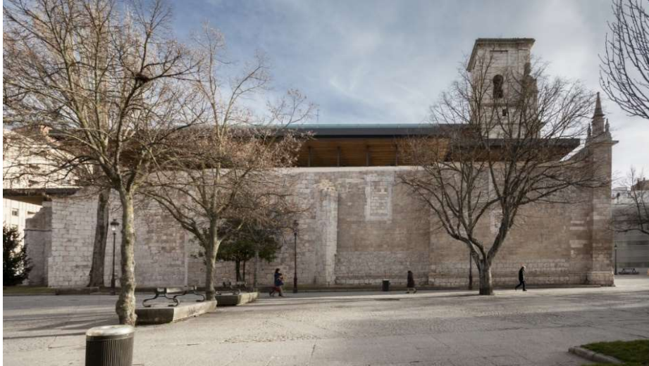
Fotografía 2. Cubierta Monasterio de San Juan - Vista lateral. Fuente: Santiago Escribano Martínez
