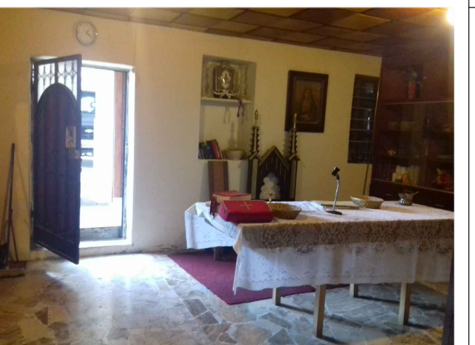
Patología: Humedad, deformación, suciedad 7.- Falta de mantenimiento en la sacristía, humedad en las paredes y deformación de cielo raso
