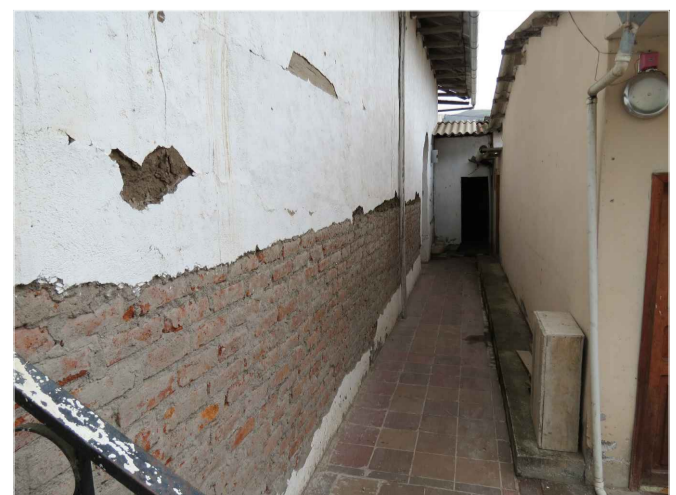
Patología: Humedad, desprendimiento de revestimientos 3.- Muro lateral izquierdo desprendimientos, fisuras, suciedad y trabajos ejecutados para reparar el muro
