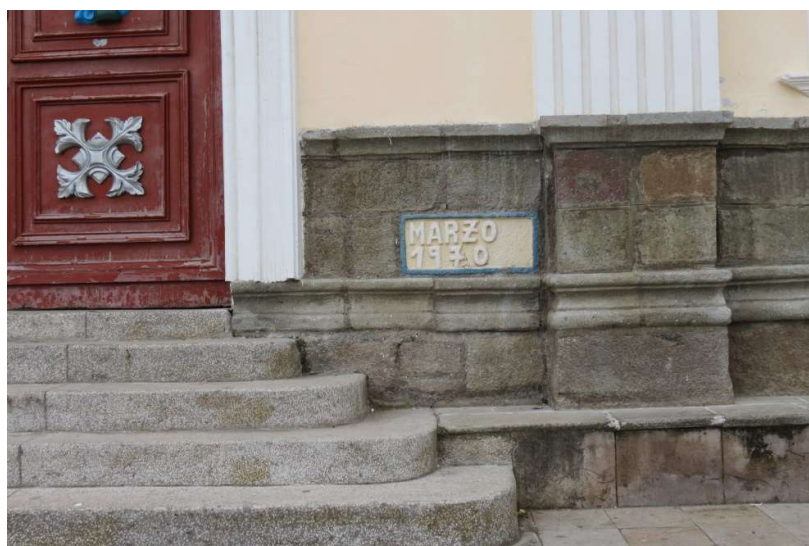
Fotografía 32. Patologías presentes al exterior de la Igleis Fuente: El Autor
