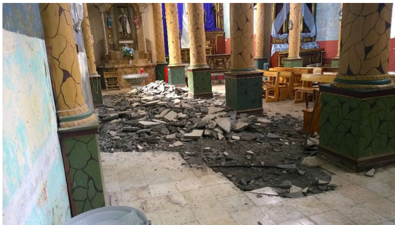
Fotografía 28. Liberación de baldosa hidráulica Fuente: El Autor
