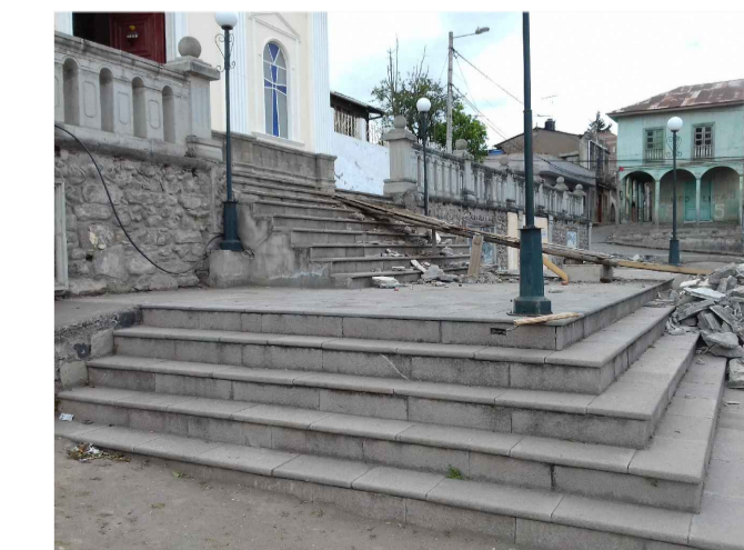
Patología: Humedad, organismos, eflorescencias 13 - Graderío de ingreso desde la plaza a la iglesia en mal estado por la falta de mantenimiento
