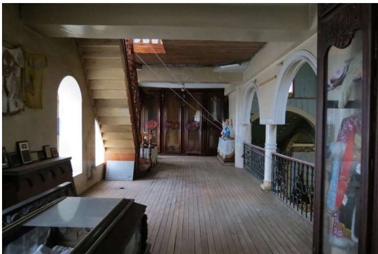
Fotografía 30. Humedad en la unión viga - entrepiso Fuente: El Autor
