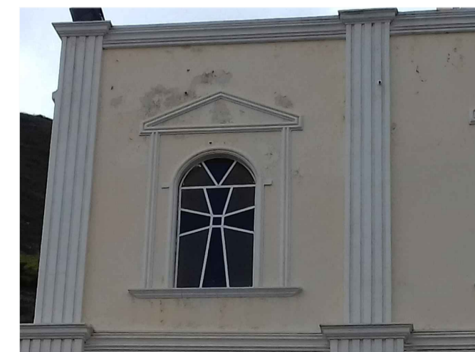
Patología: Humedad, desprendimientos 10 - Humedad, suciedad, desprendimientos de acabados en la fachada principal
