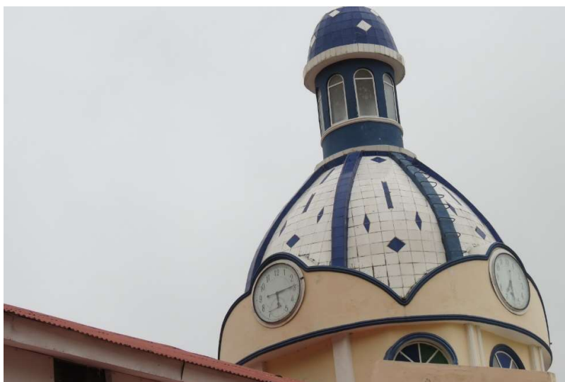
Fotografía 31. Afectaciones en la cúpula Fuente: El Autor
