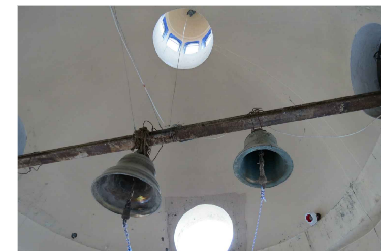
Patología: Humedad, desprendimientos 11 - Humedad, suciedad, desprendimientos en la cúpula; base que sostiene las campanas en mal estado
