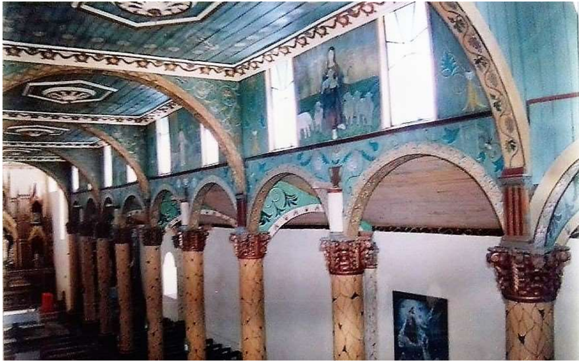
Fotografía 35. Pintura en muros perimetrales Fuente: David Santillán
