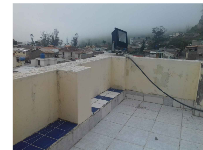
Patología: Humedad, desprendimientos 12 - Antepecho de la terraza con materiales en mal estado, presencia de humedad
