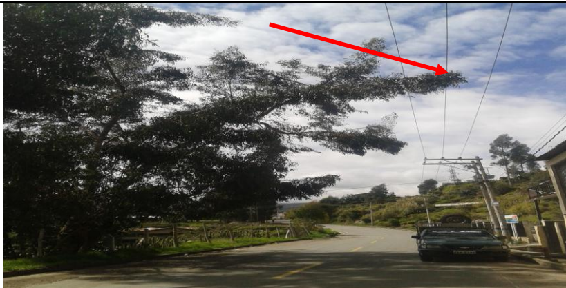
Ramas de árboles sobre los cables de alta tensión (Lado frontal del camal)
