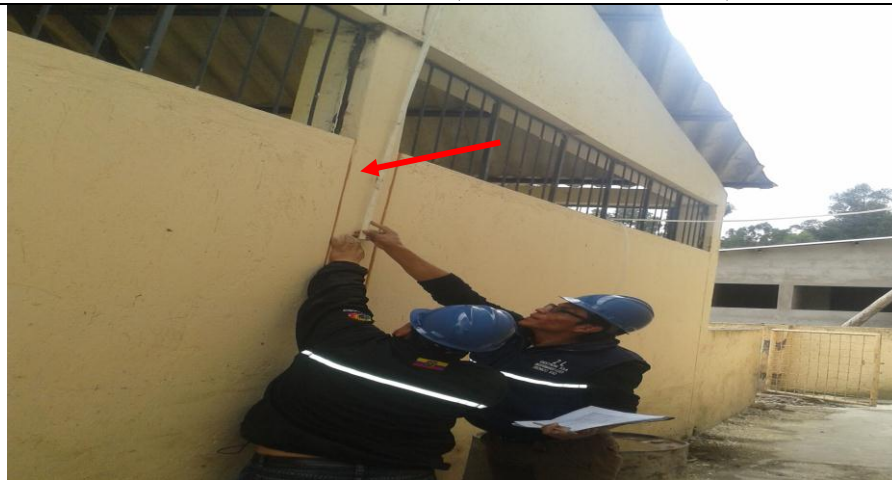
Medición de la altura de la nave 2 (nave de faenamiento)
