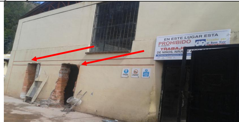
Primeros cambios (Apertura de dos puertas para el ingreso principal a la nave de bovinos).
