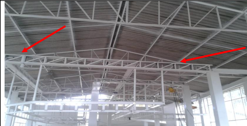
Implementación de la pintura en las infraestructuras metálicas.
