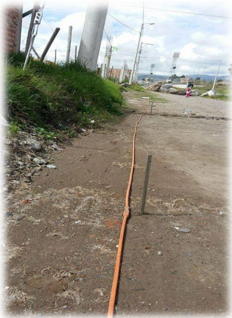
Introducción de electrodos en el suelo
