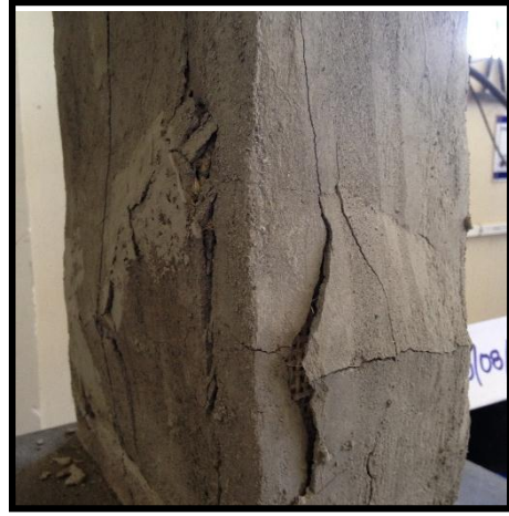
Falla pila C/R 2
