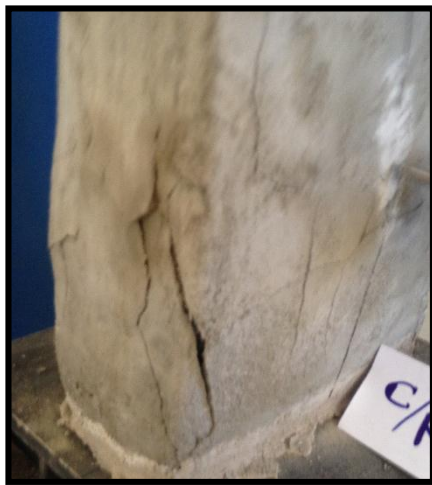
Falla pila C/R 3
