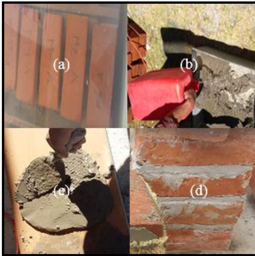
Figura 60. Procedimiento para la elaboración de columnas:(a) humedecer los ladrillos, (b) mezcla del mortero, (c) colocación de mortero (d) pila finalizada
