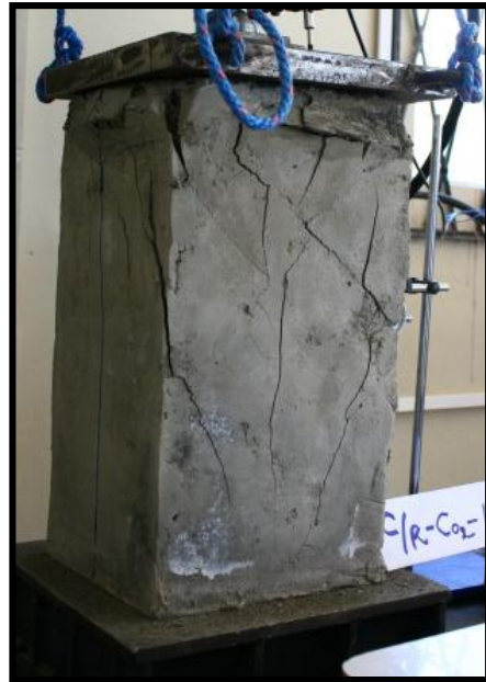
Falla columna concéntrica C/R 2
