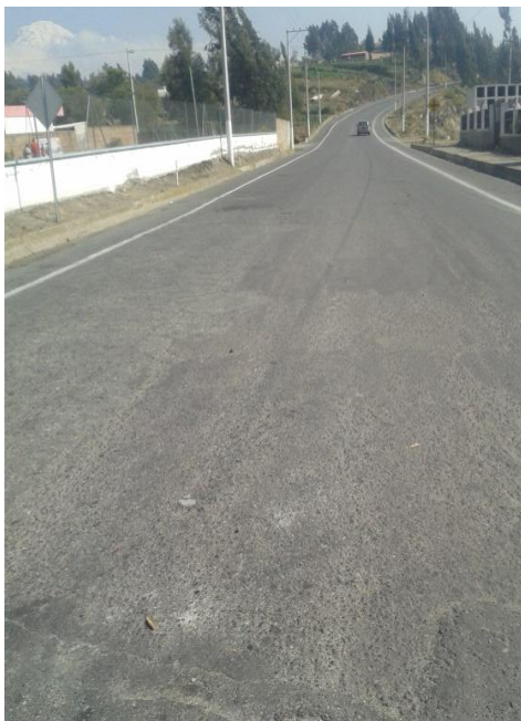
Fotografía 2 No existe señalización reglamentaria de límite de velocidad Abscisa 0+000
