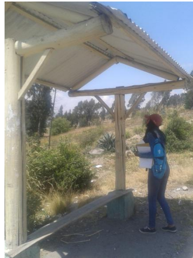
Fotografía 35 Refugio peatonal con grietas en la madera, no presenta señalización de Parada de Bus. Abscisa 1+900
