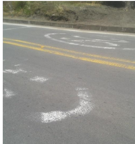
Fotografía 26 Señalización horizontal poco legible. (Ubicación Tramo 2)
