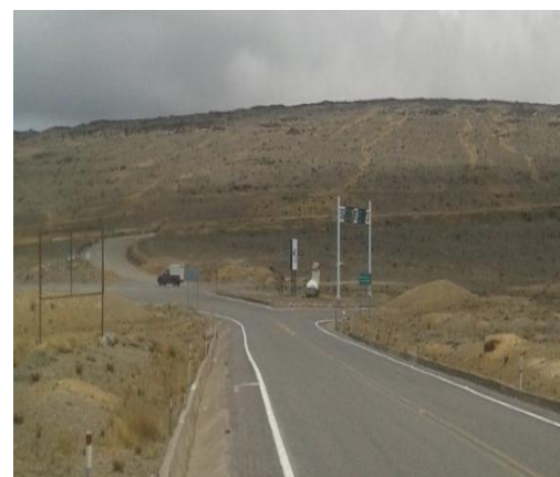
Fotografía 43 No existe señalización de Parada de Bus, tampoco existe refugio peatonal en el Empate vía Ambato Guaranda. Abscisa 40+100
