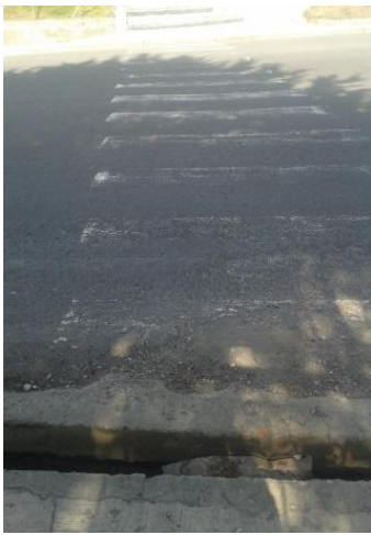
Fotografía 30 Señalización peatonal borrosa en el Cementerio de Calpi Abscisa 0+010 Obtención fotográfica: Margoth Tenesaca
