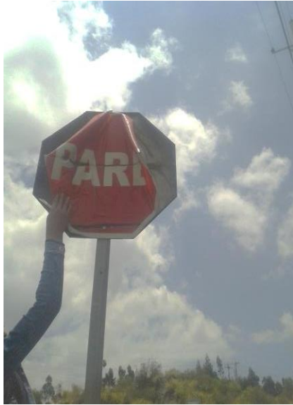
Fotografía 16 Señalización regulatoria en mal estado. Abscisa 3+200
