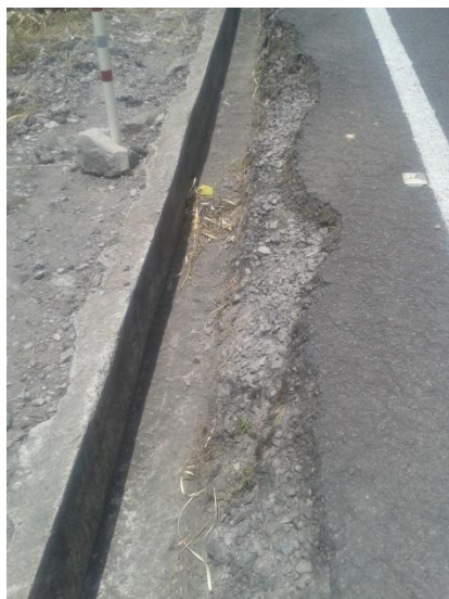
Fotografía 6 Borde de berma deteriorada. Abscisa 2+500
