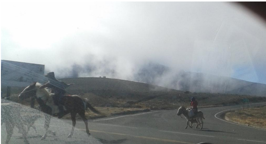
Fotografía 55 Falta señalización preventiva para animales en la vía en el Empate vía Ambato Guaranda. 40+000
