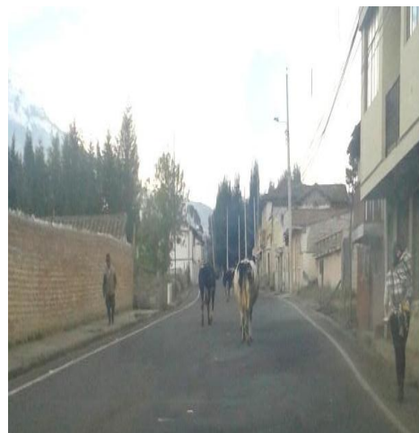
Fotografía 53 Falta señalización preventiva para animales en la vía. Abscisa 8+400
