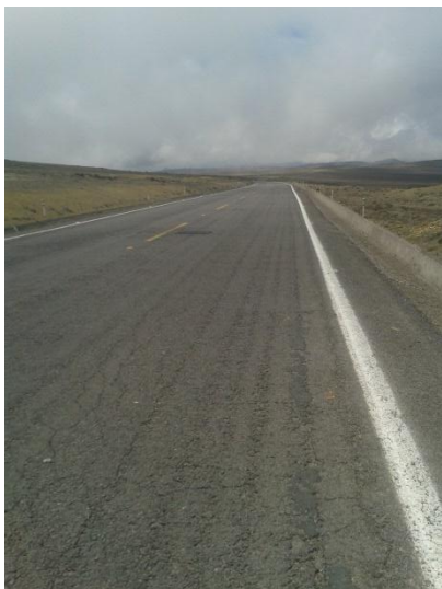
Fotografía 23 Falta señalización preventiva para animales en la vía. Abscisa 29+500
