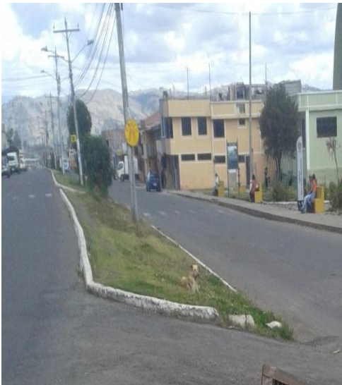
Fotografía 18 Falta contraste en la señal preventiva de cruce peatonal. Abscisa 6+300
