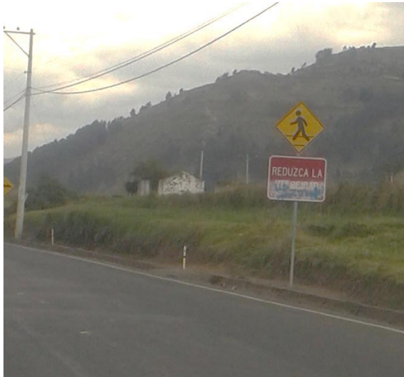
Fotografía 4 Señalización reglamentaria de advertencia de velocidad con insuficiente contraste. Abscisa 7+400
