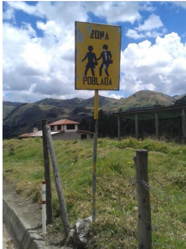
Fotografía 20 Desgaste de señalización de zona poblada. Abscisa 9+000
