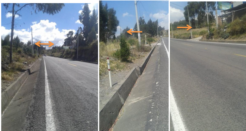
Fotografía 11 Intersección sin señalización y demarcaciones que anticipen la presencia de la misma, presenta una superficie de ripio suelto. Abscisa 1+800
