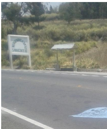
Fotografía 36 Refugio peatonal no presenta señalización de Parada de Bus. Abscisa 2+300
