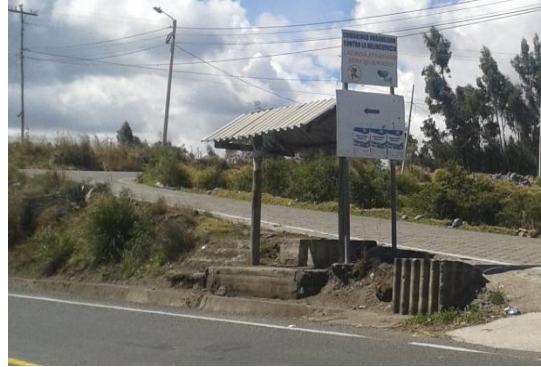
Fotografía 39 Refugio peatonal no presenta señalización de Parada de Bus. Abscisa 3+010
