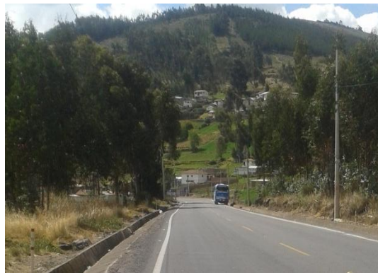
Fotografía 48 No existe una adecuada señalización de estacionamiento. Abscisa 4+300
