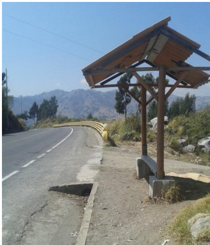
Fotografía 34 Refugio peatonal deteriorado el techo, no presenta señalización de Parada de Bus. Abscisa 0+850
