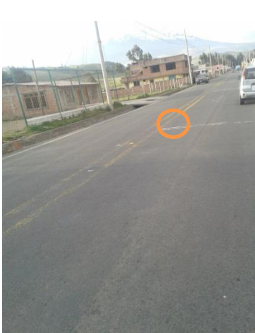
Fotografía 27 Algunas tachas desprendidas. (Ubicación Tramo 6)
