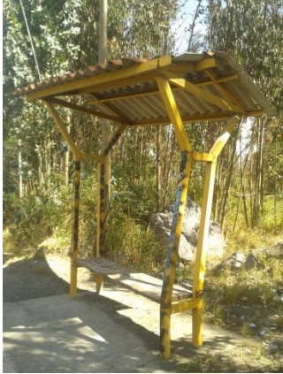
Fotografía 38 Refugio peatonal de metal golpeada en sus extremos, no presenta señalización de Parada de Bus. Abscisa 2+900
