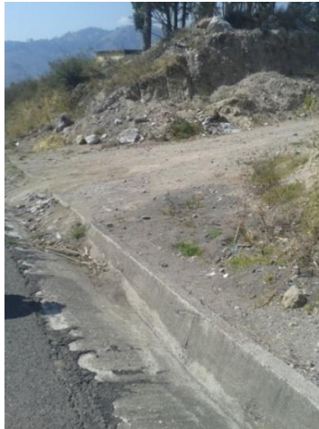
Fotografía 10 No existe demarcación del pavimento y señales que regulan la intersección satisfactoriamente. Abscisa 0+200
