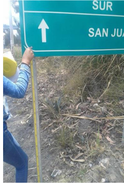
Fotografía 17 Señal informativa en la intersección NUVIDAT S.A presenta una altura de 1.25 m por lo que no cumple con altura mínima de 2.00 m Abscisa 3+700
