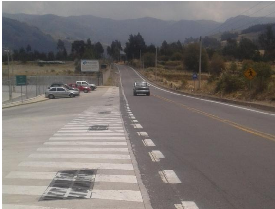
Fotografía 47 Zona de estacionamiento. Abscisa 3+800 (Tramo 2)
