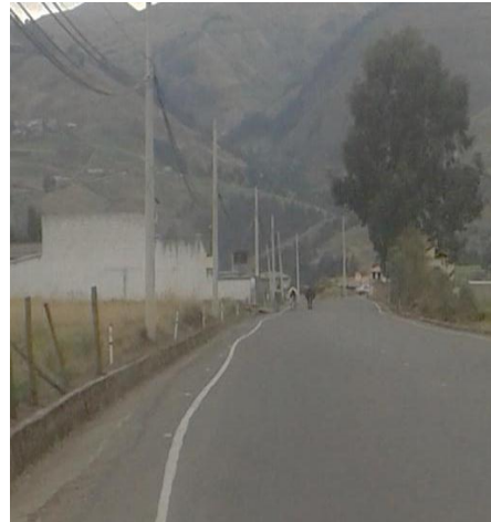
Fotografía 28 Señalización horizontal de borde sin una adecuada alineación con la vía. (Ubicación Tramo 5)
