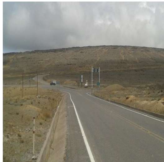
Fotografía 5 No existe señalización reglamentaria de límite de velocidad Abscisa 40+200
