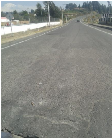
Fotografía 25 Señalización mediana horizontal desgastada. (Ubicación Tramo 1)
