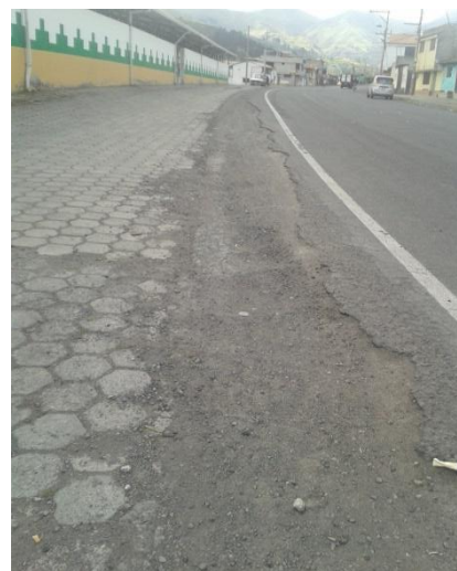
Fotografía 7 Pavimento de la berma totalmente deteriorado. Abscisa 6+000
