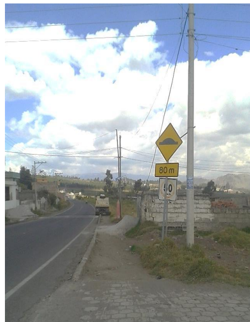
Fotografía 3 Señalización reglamentaria de límite de velocidad sin una adecuada visibilidad para los usuarios Abscisa 5+750
