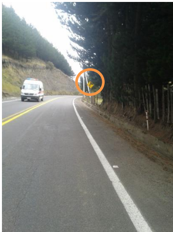
Fotografía 21 Visibilidad de señalización preventiva obstruida por árboles. Abscisa 16+900
