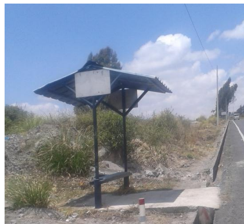
Fotografía 37 Refugio peatonal no presenta señalización de Parada de Bus. Abscisa 2+500
