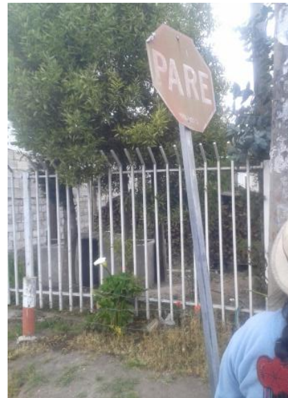
Fotografía 19 Señalización regulatoria "PARE" sin una adecuada visualización, obstruida por un poste. Abscisa 7+750
