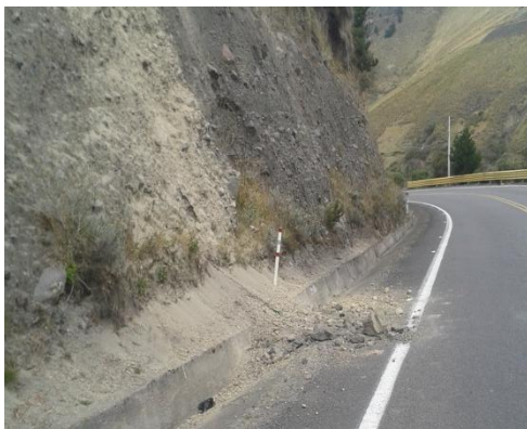
Fotografía 44 Deslizamientos de talud. Ubicación Tramo 10 Obtención fotográfica: Margoth Tenesaca
