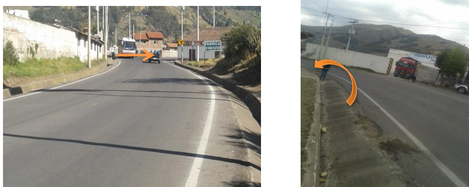
Fotografía 12 Intersección hacia Shobolpamba no presenta una adecuada visibilidad Abscisa 7+800
