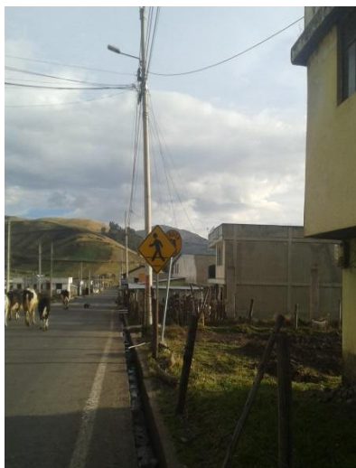
Fotografía 32 Señalización de "cruce" sin una adecuada visualización, obstruida por otra señalización en la comunidad de Guabug Abscisa 10+710 Obtención fotográfica: Margoth Tenesaca
