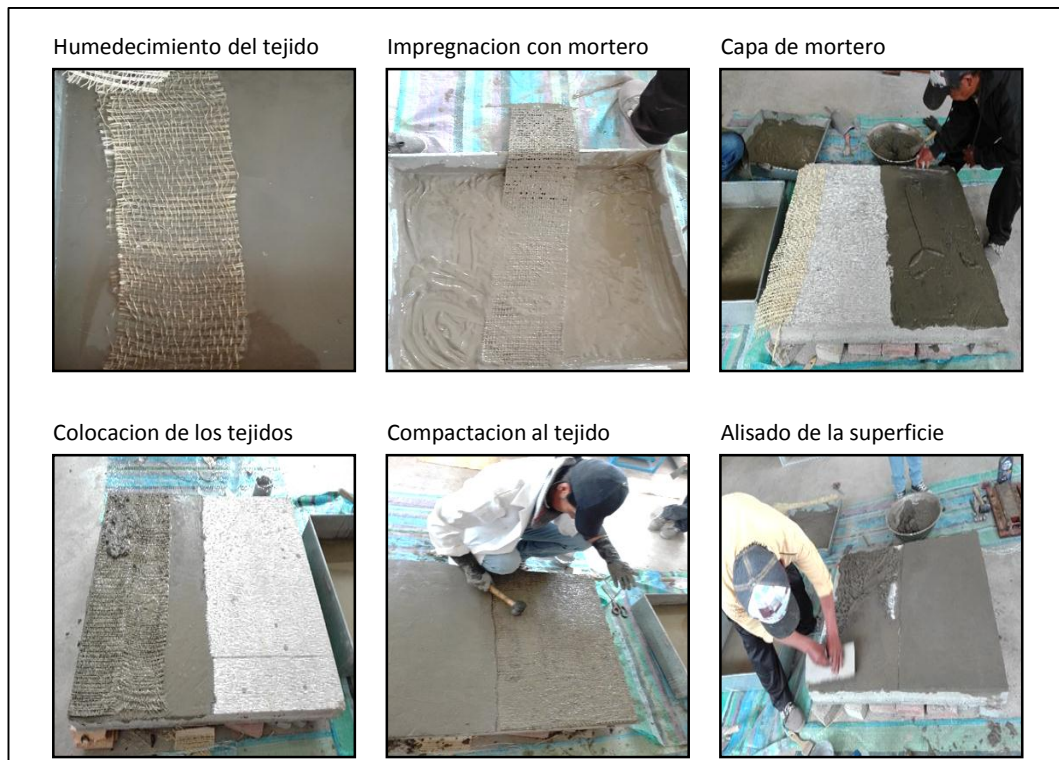
Figura 52. Colocación del material compuesto FRCM.
