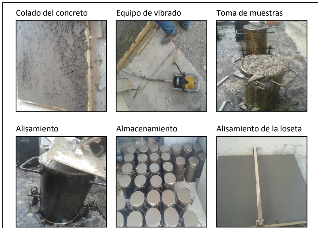
Figura 48. Elaboracion de losetas de concreto y toma de muestras.
