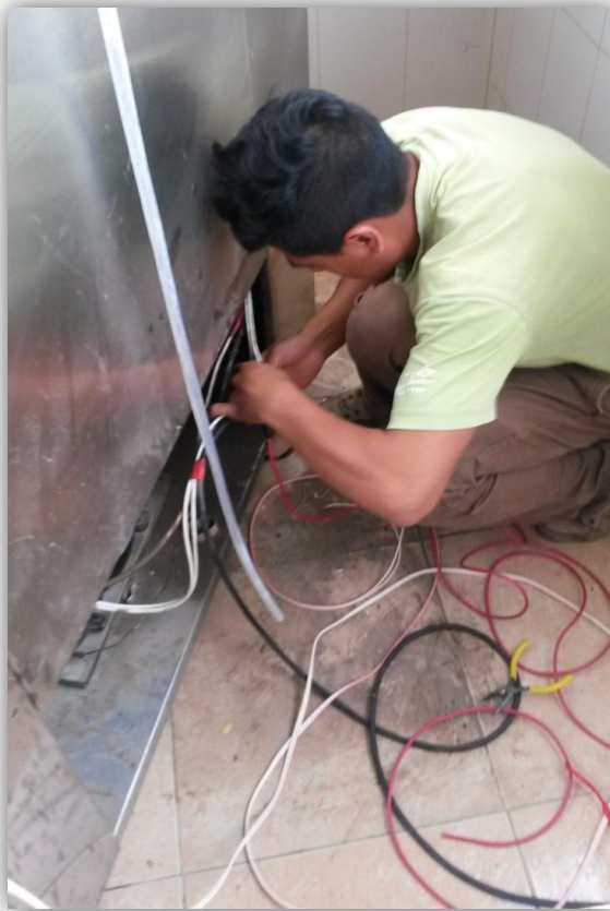
Figura 21.- Verificación cable de alimentación en cortocircuito. Fuente: Autores.
