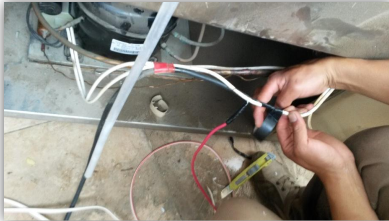
Figura 25.- Empalme y aislamiento cable calibre 10AWG.
