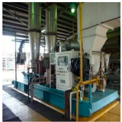
ÁREA DE TURBINA
