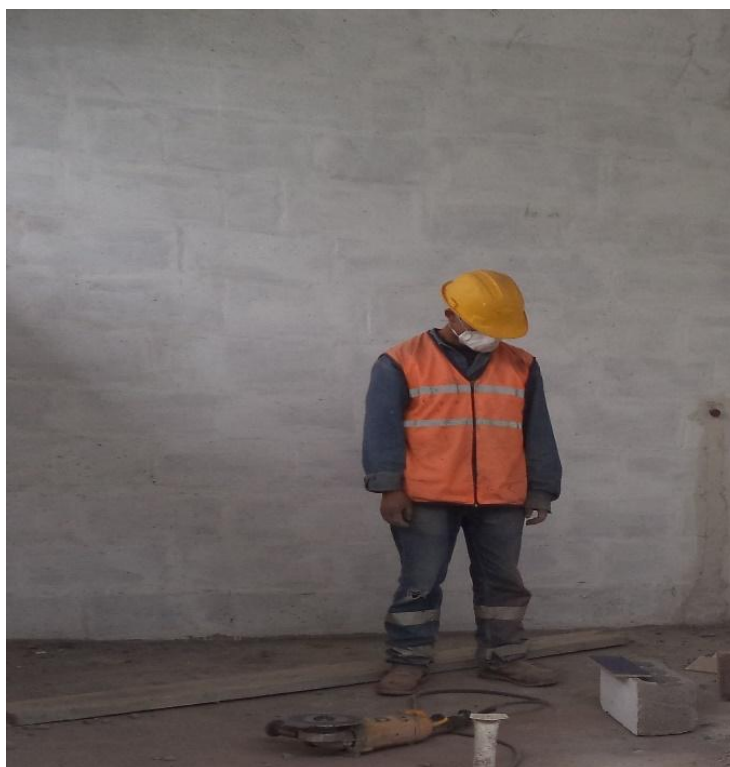
Ilustración 4.21. Equipo de protección usado para las actividades de corte
