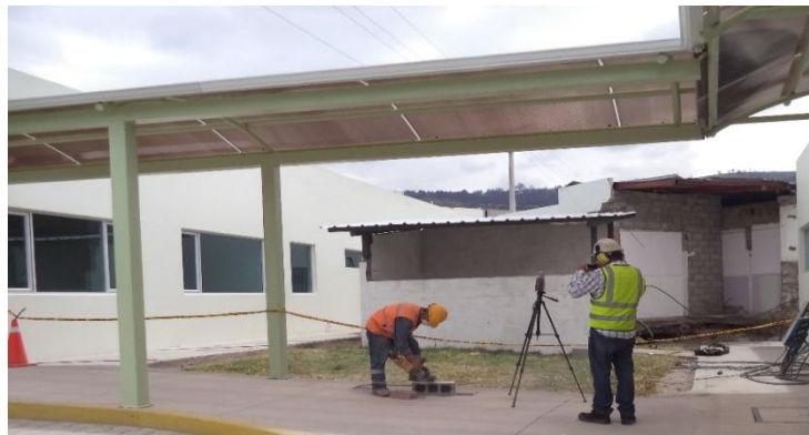
Ilustración 4.38. Monitoreo de material particulado para corte de porcelanato
