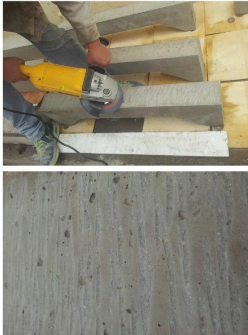
Figura 91: Preparación de la Superficie mediante cortes transversales
