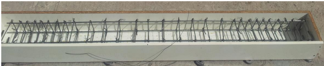
Figura 101: Modelo de Viga- Fotografía
