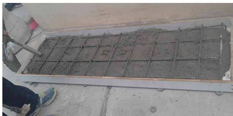
Figura 86: Ensayo Pull Of- Fundición de la losa de ensayo.
