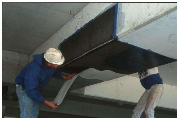
Figura 15: Aplicación del sistema FRCM.
