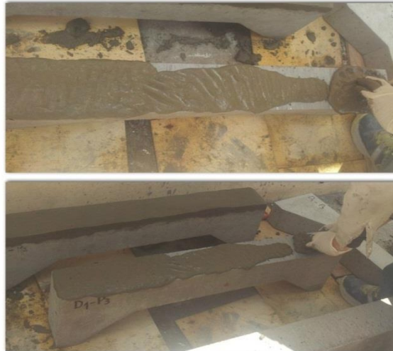
Figura 107: Colocación de la primera capa de mortero en vigas y columnas.
