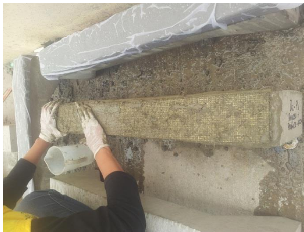
Figura 109: Compactación con la manos de la malla en la capa de mortero. Después de dejarlo fraguar algunas horas, se procede a colocar papel absorbente para evitar la evaporación del agua.
