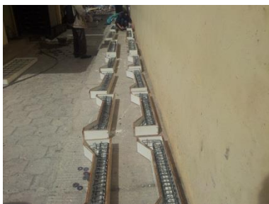
Encofrados y armado de elementos de hormigón
