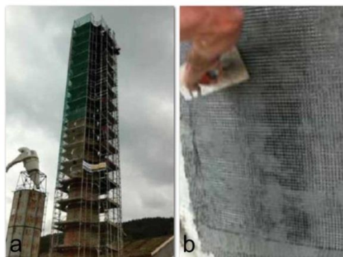
Figura 26. a) Chimenea a reparar, b) Aplicación del sistema FRCM FUENTE: Universidad de Chile-Pablo Sandoval
