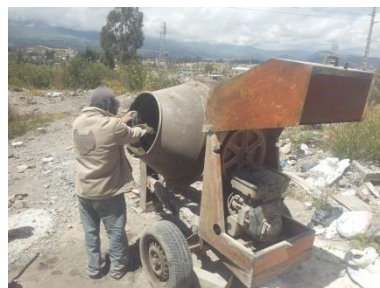
Concretera para fundición de elementos de hormigón armado
