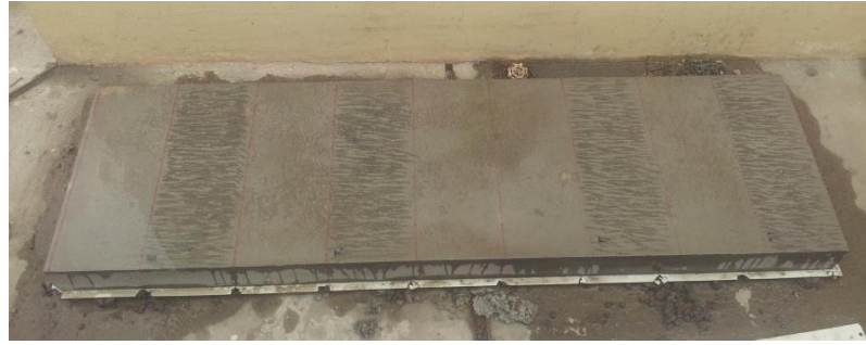
Figura 87: Ensayo Pull Of- Preparación de zonas para adherencia del material compuesto FRCM.
