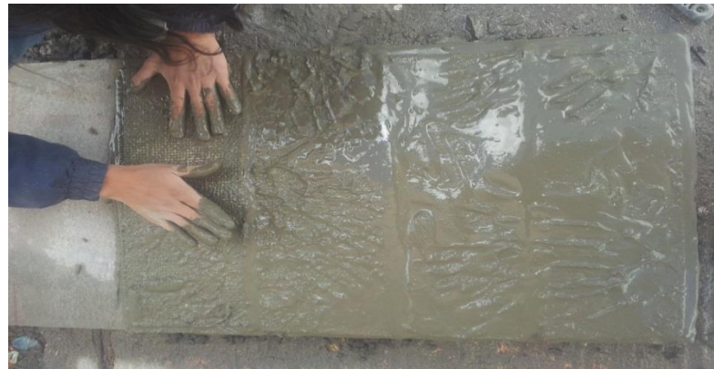
Figura 88: Ensayo Pull Of- Colocación del Material compuesto FRCM sobre la losa de hormigón.
