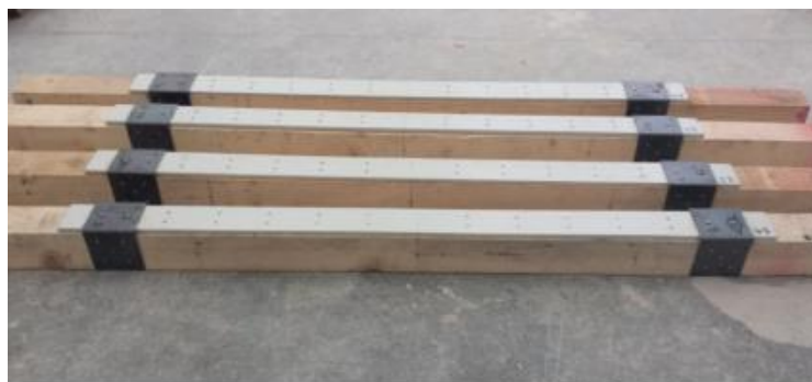
Figura 276: Las cuatro vigas pequeñas después de la aplicación de la armadura de acero. Fuente: Marco Corradi, 2016
