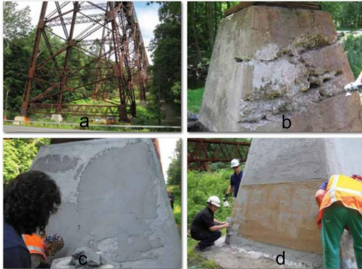
Figura 25. a) Puente a reparar, b) Agrietamiento del pedestal, c) Reparación de fisuras, d) Aplicación del sistema FRCM. FUENTE: Universidad de Chile-Pablo Sandoval
