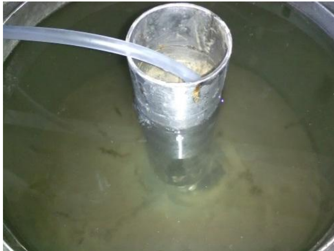
Figura 58. Colchón de lodos.
