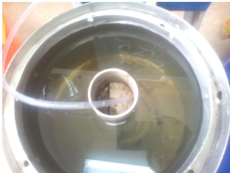
Figura 45. Formación del colchón de lodos del clarificador
