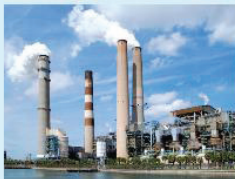
FIG. 2 TERMOELÉCTRICA DE ESMERALDAS
