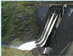
FIG. 1 REPRESA HIDROELÉCTRICA DE PAUTE
