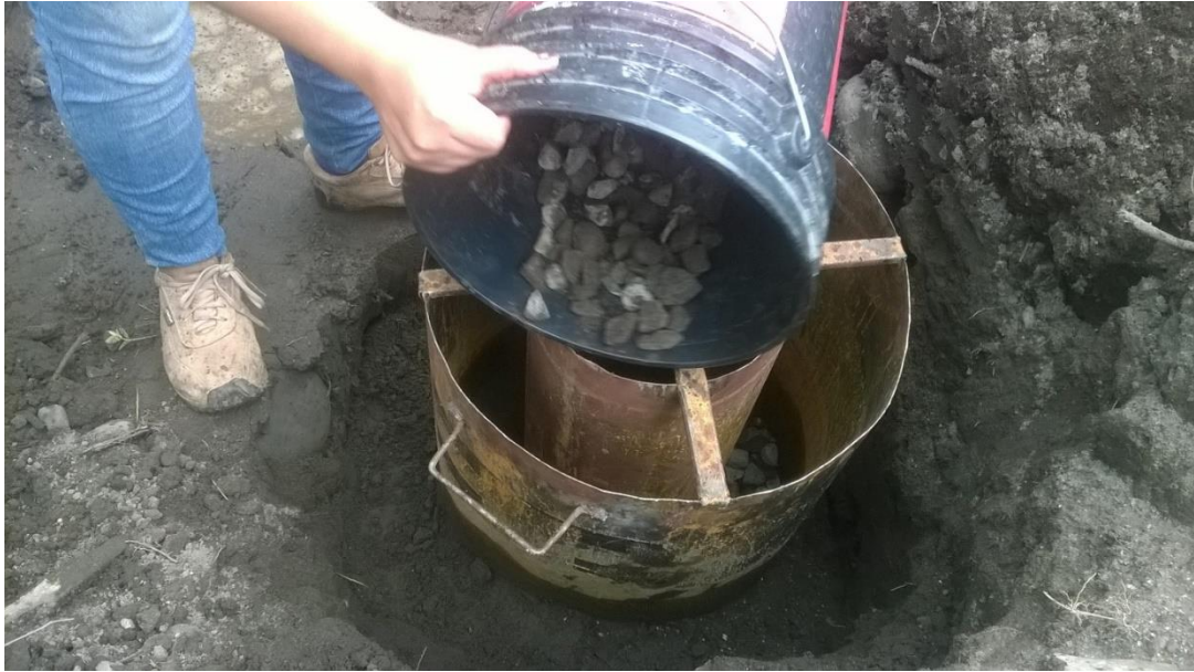
Fotografía 12.- Colocación de agregado de 3/4", con un espesor de 5cm para evitar socavamiento, calicata 1, parroquia Madre Tierra. Elaborado por: Cinthya Lema, Jairo Allauca/2016.
