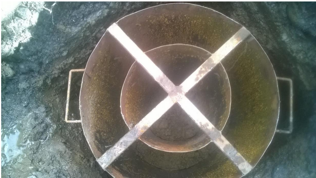
Fotografía 11.- Colocación de cilindro doble en la gaveta de calicata 4, parroquia Veracruz. Elaborado por: Cinthya Lema, Jairo Allauca/2016.
