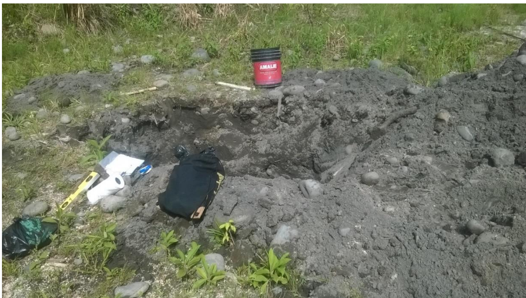
Fotografía 7.- Excavación de calicata 1, parroquia Madre Tierra. Elaborado por: Cinthya Lema, Jairo Allauca/2016.
