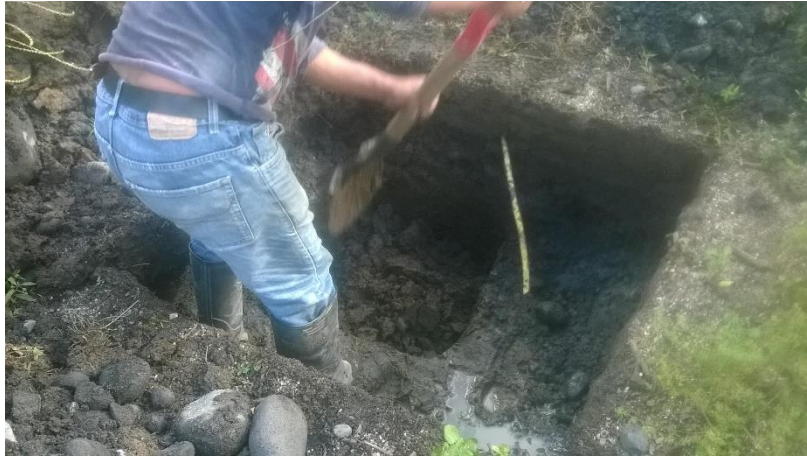
Fotografía 1.- Excavación de calicata.
