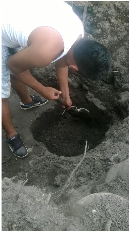
Fotografía 9.- Excavación de gaveta en calicata 3, parroquia Madre Tierra
