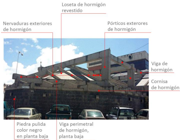
Fotografía 12. Detalle y descripción de materiales de Estructura esquelética que soporta la loseta de cubierta del auditorio; sobre las calles Veloz y Juan Montalvo. Fuente: Eduardo Rivadeneira.
