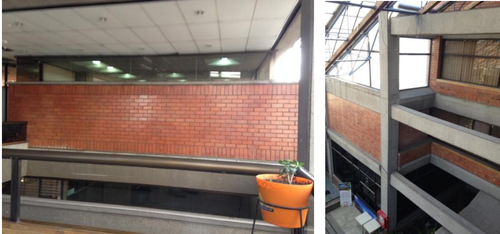
Fotografía 20. Mampostería interior de ladrillo. Fuente: Eduardo Rivadeneira
