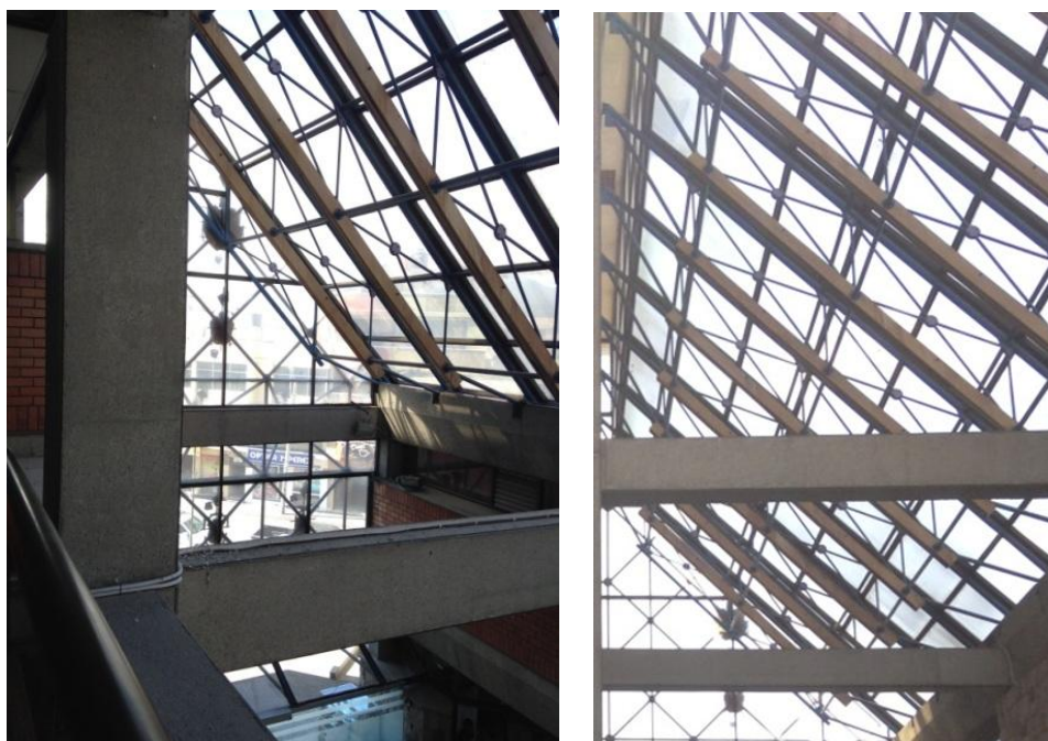
Fotografía 19. Cerchas interiores de acero y madera que soportan armadura y cubierta de vidrio templado. Fuente: Eduardo Rivadeneira.
