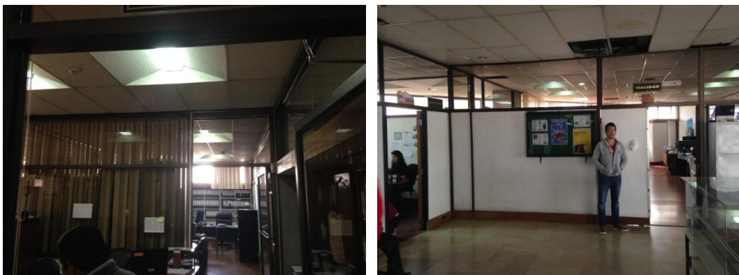
Fotografía 22. Divisiones de espacios con mamparas, destinados a oficinas. Fuente: Eduardo Rivadeneira
