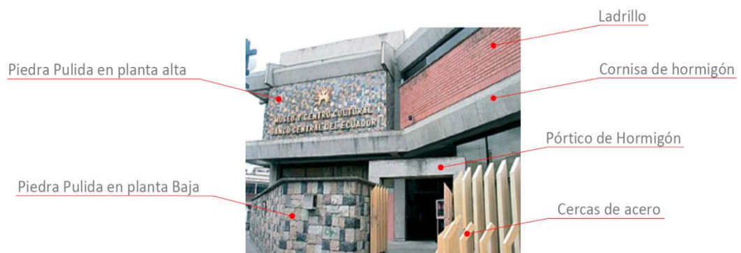
Fotografía 9. Detalle y descripción de materiales de volumen e ingreso que destaca sobre la calle Veloz. Fuente: Eduardo Rivadeneira.
