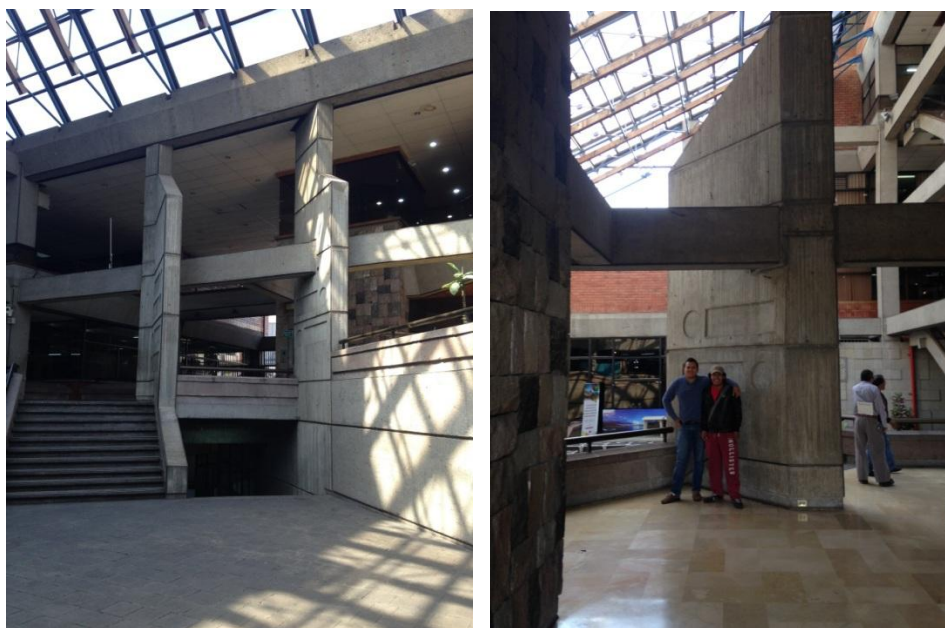
Fotografía 18. Diafragmas laterales de hormigón armado en área de transición. Fuente: Eduardo Rivadeneira.
