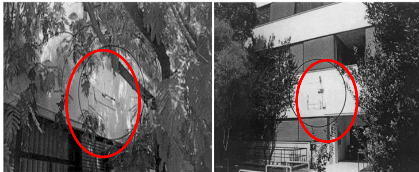
Figura 31. Colocación de los aparatos de medición de temperatura en paredes exteriores con sombra y sin sombra. Fuente: (KONTOLEON., K.J., & E.A., 2010)
