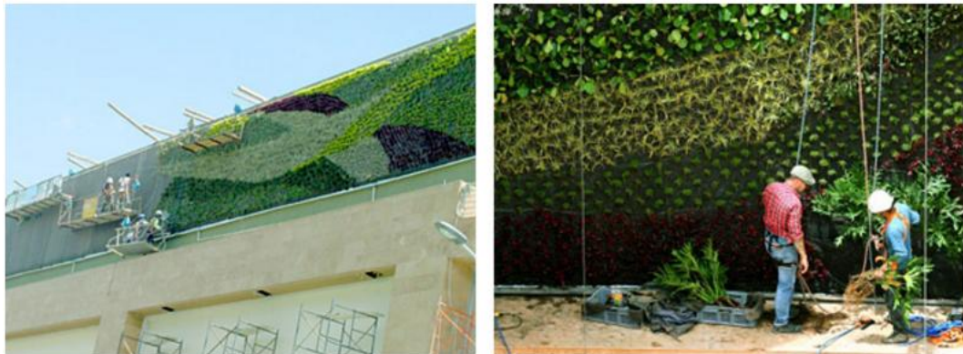
Figura 46. Colocación de plantas en jardines verticales interiores y exteriores del centro comercial Scala Quito. Fuente: (Solano, 2012)
