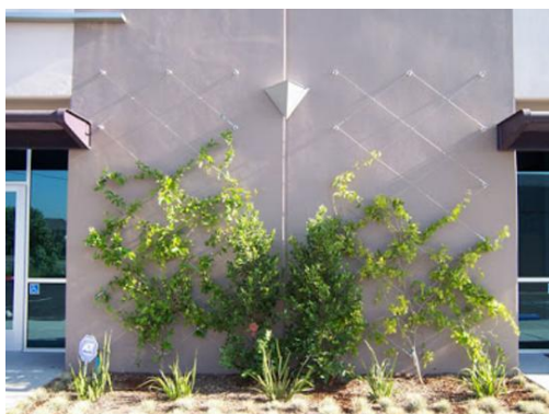
Figura 9. Sistema de cables de Carl Stahl DécorCable. Fuente: http://www.urbanarbolismo.es/blog/fachada-vegetal-sistemas-constructivos/
