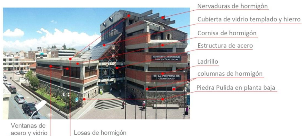
Fotografía 5. Descripción de materiales en Edificio del Consejo Provincial de Chimborazo, vista sobre calles Primera Constituyente y Carabobo. Fuente: Eduardo Rivadeneira.
