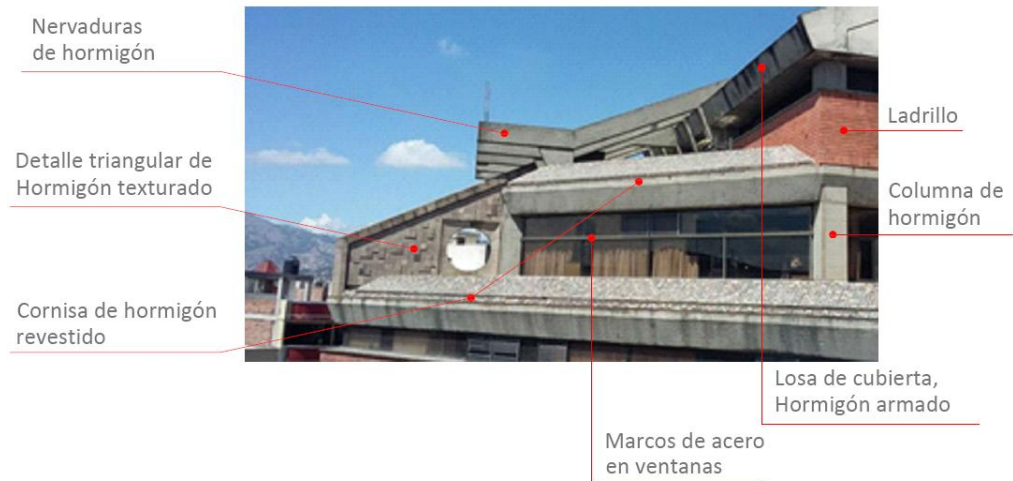
Fotografía 10. Detalle y descripción de materiales de remate del edificio que destaca sobre la calle Primera Constituyente y Carabobo, esquina. Fuente: Eduardo Rivadeneira.
