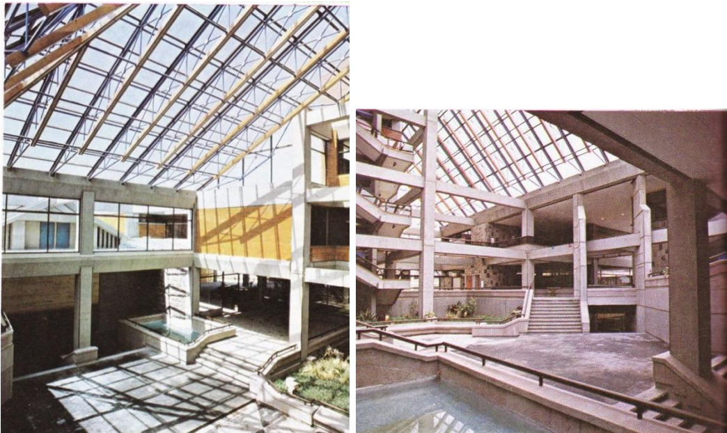
Fotografía 4. Interiores del Edificio del Consejo Provincial de Chimborazo (épocas de Banco Central sucursal Riobamba). Fuente: (Rolando Moya , 1986)
