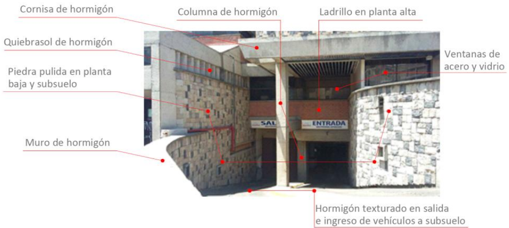
Fotografía 11. Detalle y descripción de materiales de salida e ingreso de vehículos a subsuelo; sobre las calles Veloz y Carabobo, esquina. Fuente: Eduardo Rivadeneira.
