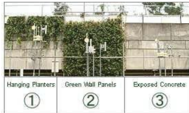
Figura 29. Instalación de los instrumentos de medición en pared cubierta y descubierta de plantas trepadoras. Fuente: (Hoyano, 1998)
