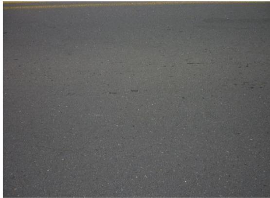
**Fotografía 25.** Agregado pulido, severidad baja
