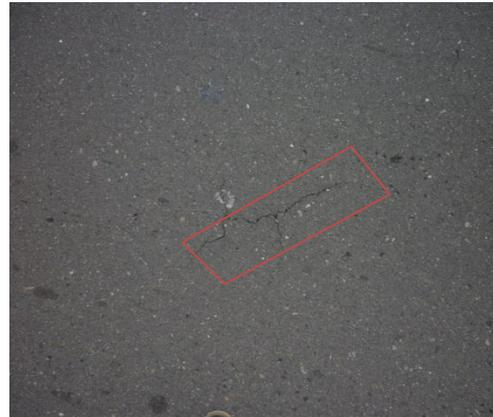
**Fotografía 24.** Fisura transversal, severidad baja
