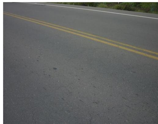
**Fotografía 27.** Agregado pulido, severidad baja
