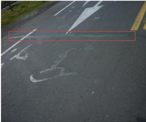
**Fotografía 1.** Fisura transversal, severidad baja
