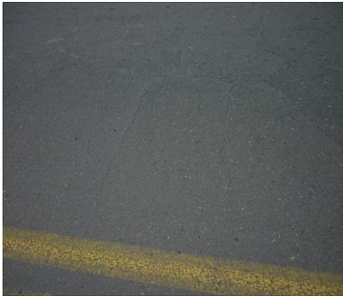
**Fotografía 13.** Agregado pulido, severidad baja
