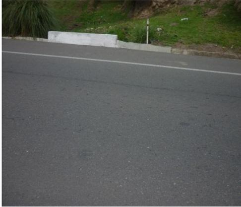
**Fotografía 28.** Agregado pulido, severidad baja
