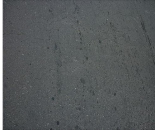
**Fotografía 6.** Agregado pulido, severidad baja
