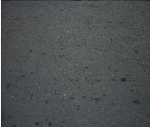
**Fotografía 7.** Agregado pulido, severidad baja
