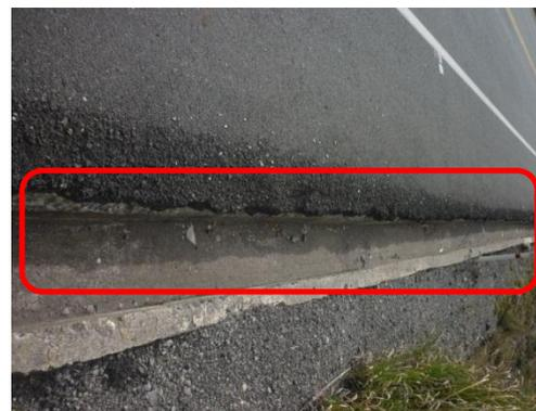
**Fotografía 39.** Fisuramiento en borde, severidad baja
