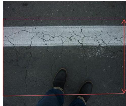
**Fotografía 10.** Fisuramiento en bloque, severidad media
