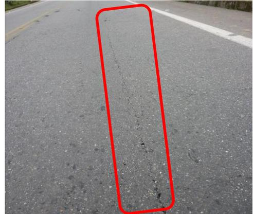
**Fotografía 58.** Fisura longitudinal, severidad baja
