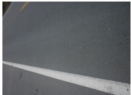
**Fotografía 33.** Agregado pulido, severidad baja
