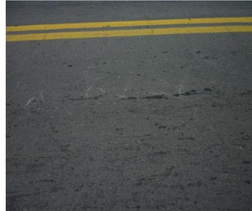
**Fotografía 8.** Agregado pulido, severidad baja
