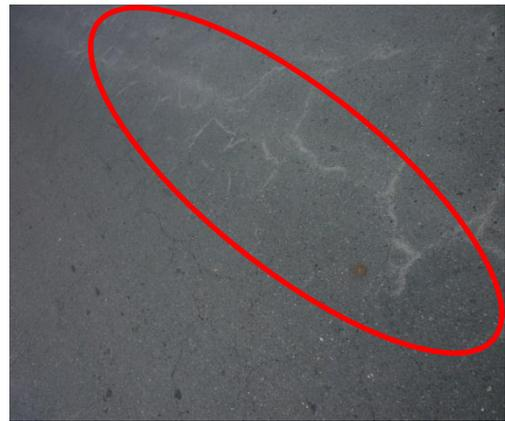
**Fotografía 31.** Fisura longitudinal, severidad baja
