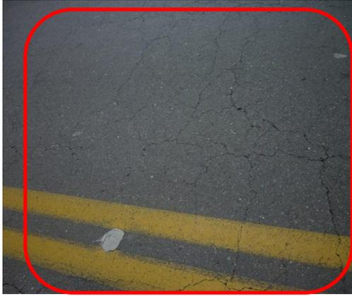
**Fotografía 46.** Fisuramiento en bloque, severidad media
