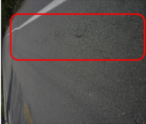
**Fotografía 55.** Fisura longitudinal, severidad baja
