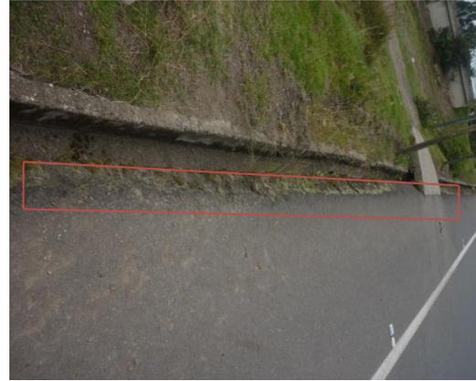
**Fotografía 29.** Fisura de borde, severidad media
