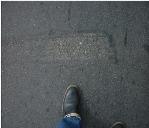
**Fotografía 17.** Agregado pulido, severidad baja
