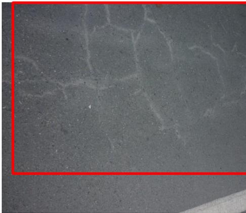
**Fotografía 30.** Fisuramiento en bloque, severidad baja
