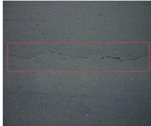
**Fotografía 18.** Fisura longitudinal, severidad media
