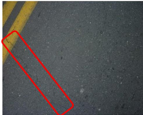
**Fotografía 43.** Fisura transversal, severidad baja
