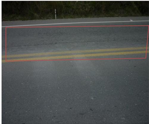
**Fotografía 14.** Fisuramiento en bloque, severidad baja
