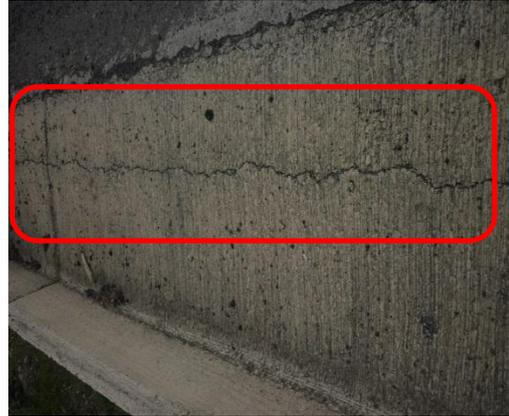
**Fotografía 56.** Fisura longitudinal, severidad baja
