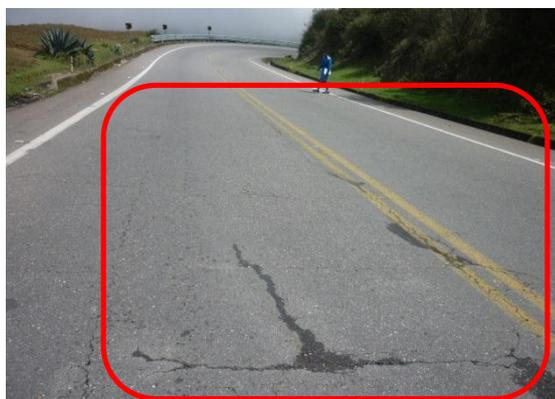
**Fotografía 59.** Fisuramiento en bloque, severidad baja
