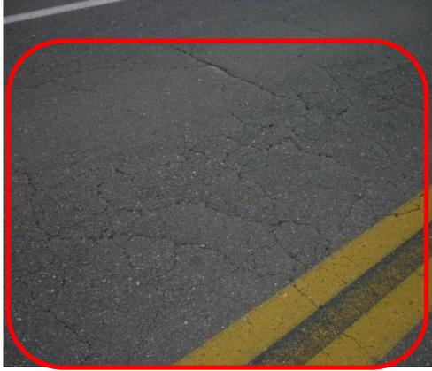
**Fotografía 51.** Fisuramiento en bloque, severidad media
