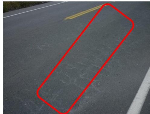
**Fotografía 37.** Fisuramiento en bloque, severidad baja
