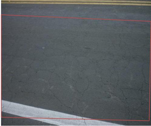
**Fotografía 5.** Fisuramiento en bloque, severidad media
