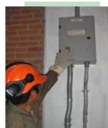
Comprobar que las cajas de conexiones eléctricas permanecen cerrados para evitar la acumulación de aserrín en ellos.
