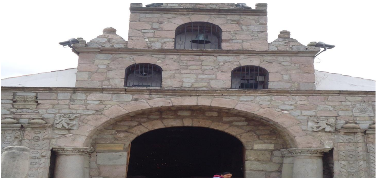
Imagen: Entrada principal de la iglesia de Balvanera Fotografía :Edith Maritza Tenelema Chilinguina
