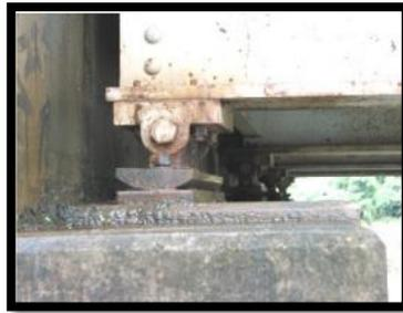
**Ilustración 21.**-Apoyo expansivo tipo patín.
