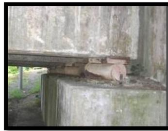
**Ilustración 22.**-Apoyo expansivo tipo rodillo.
