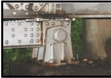
**Ilustración 24.-** Apoyo fijo de acero.
