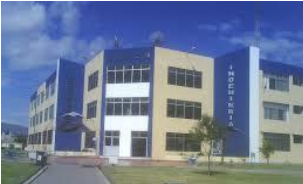
FOTOGRAFÍA N° 23: Edificio Facultad de Ingeniería Fuente: Juan Carlos Silva Merino
