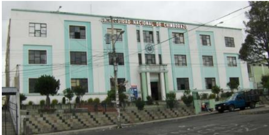
FOTOGRAFÍA N° 35: Edificio Administrativo Campus la Dolorosa
