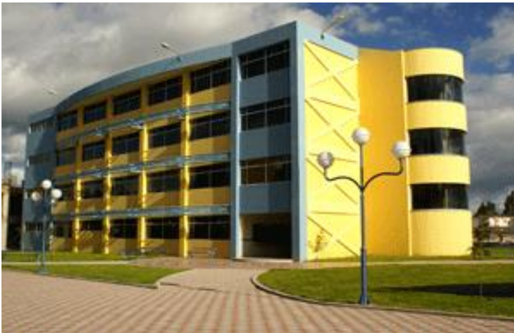
FOTOGRAFÍA N° 25: Edificio Facultad de Ciencias Políticas y Administrativas Fuente: Juan Carlos Silva Merino
