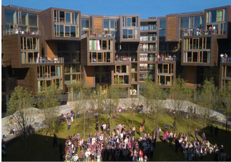
FOTOGRAFIA N° 3: Vista interior residencia universitaria Tietgen Student Hall
