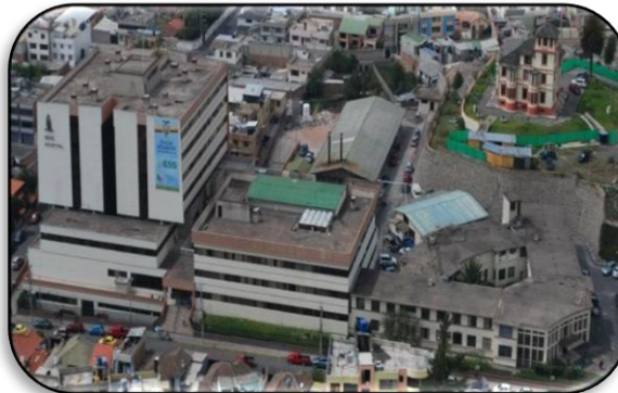
Fotografía 2 Hospital Instituto Ecuatoriano de Seguridad Social Riobamba Fuente: Cynthia Pilco y Silvana Soliz
