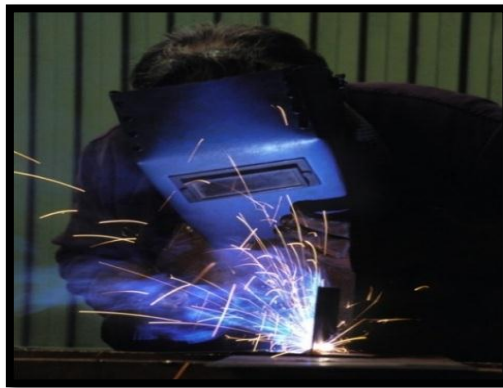
Gráfico 18: Soldadura de las partes de la estructura.
