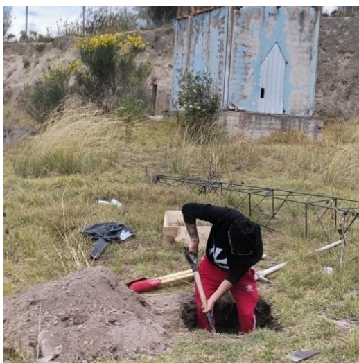
Figura 32. Excavación para montaje
