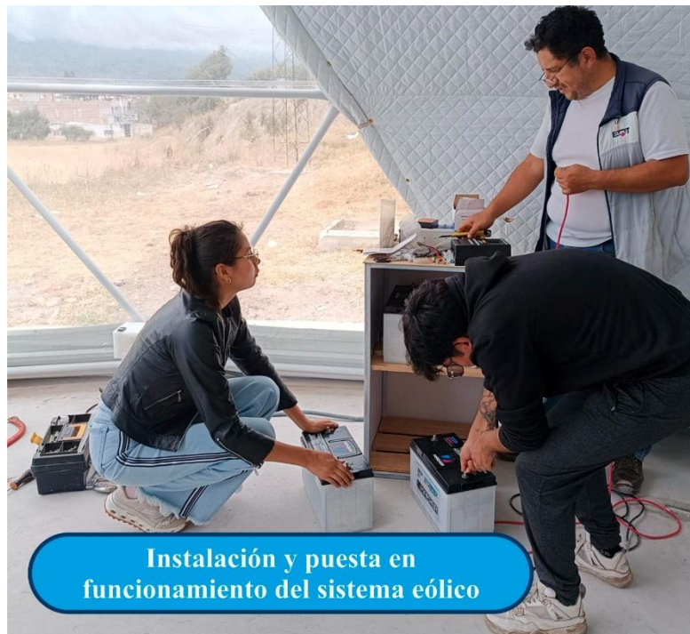
Figura 56. Instalación y armado del sistema de generación eólica
