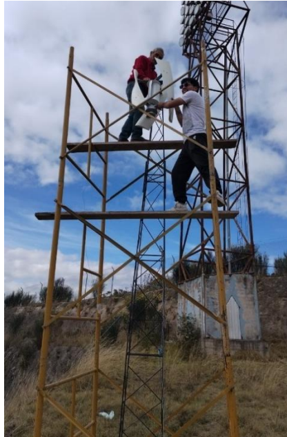
Figura 34. Montaje y Alineación del Generador Eléctrico
