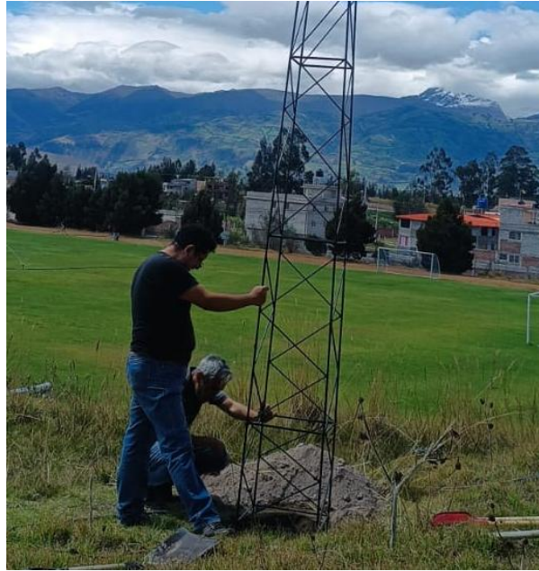
Figura 33. Excavación y anclaje
