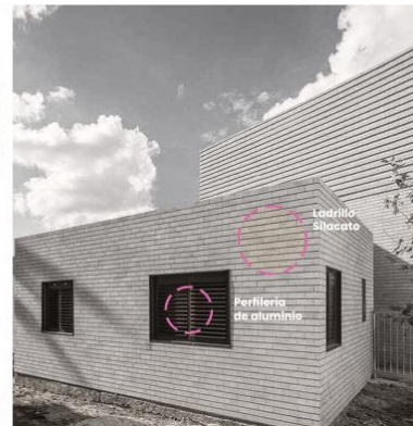
Figura 110 Vista exterior y expresión material del Refugio para víctimas de violencia doméstica Nota: Elaboración Propia
