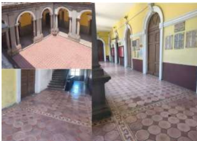
Figura 39. Pisos de patios y pasillos
