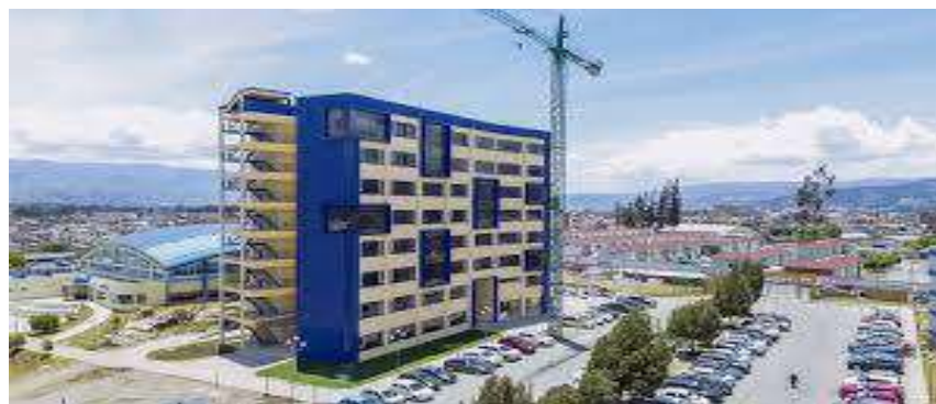
Figura 6. Instalaciones Campus Norte “Edison Riera”
