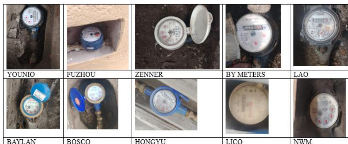
Figura 12. Marcas de medidores presentes en las redes de distribución de Alausí.
