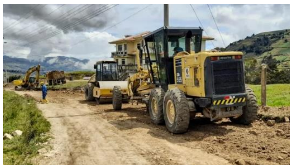
Figura 4. Proceso de conformación y estabilización mediante método de lastrado
