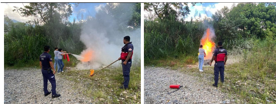
Prueba de funcionamiento del sistema contra incendios
