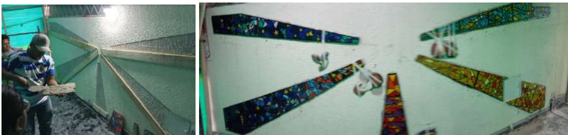
Figura 20 Pegado de cerámica sobre la pared
