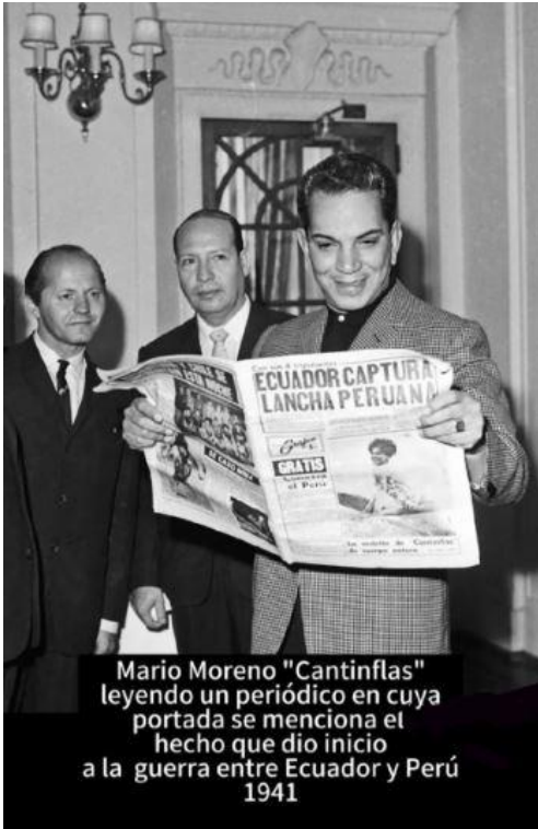
Fotografía 40: Fotografía adicional Fuente: La prensa digital Riobamba
