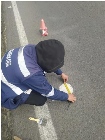
Anexo 15. Macrotextura de la carpeta de rodadura.
