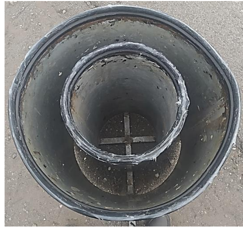
Figura 11. Colocación de silicona.
