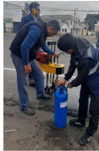
Anexo 11. Extracción de núcleos vía Panamericana E35.
