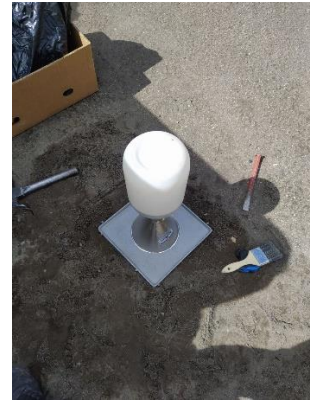
Anexo 10. Cono de arena -Subrasante.
