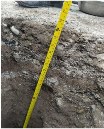
Anexo 1. Medición de espesores.
